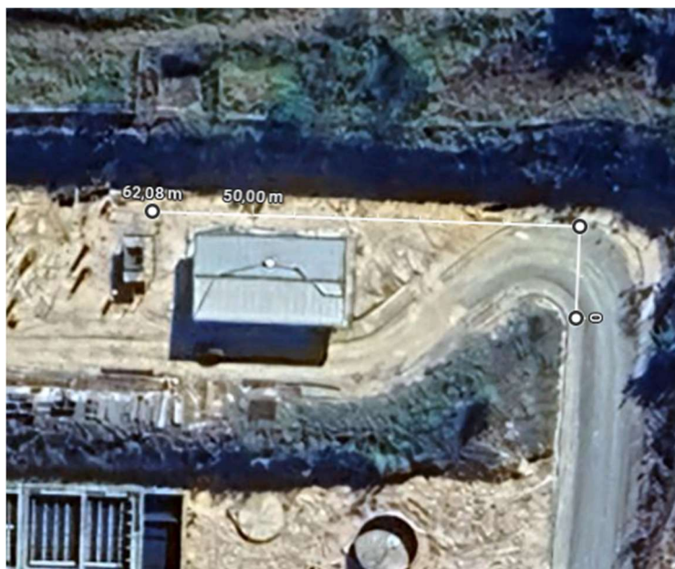
Imagem 14: Trecho complementar dentro da ETE
