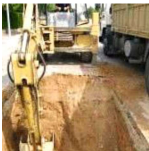
Escavação do fosso
