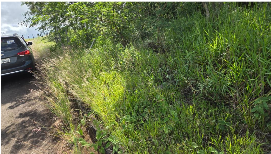
Figura 1 – Situação atual da faixa lateral da estrada.
