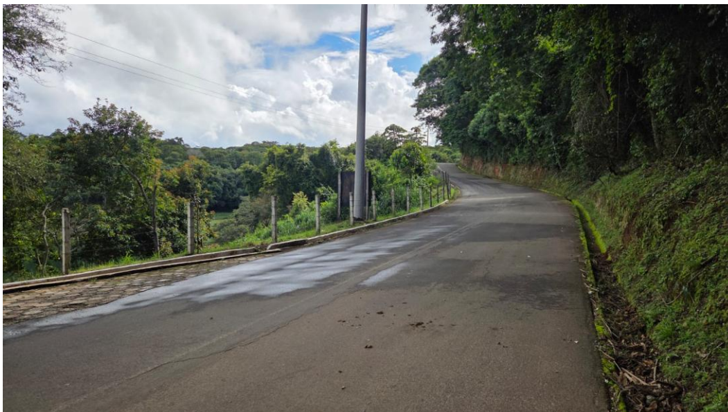
Figura 12 – Situação atual da faixa lateral da estrada.
