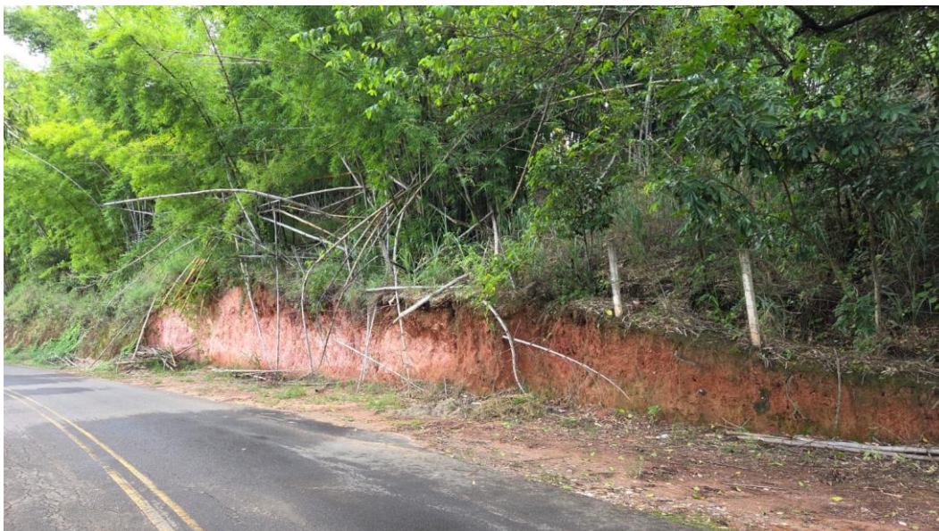
Figura 22 – Situação atual da faixa lateral da estrada.
