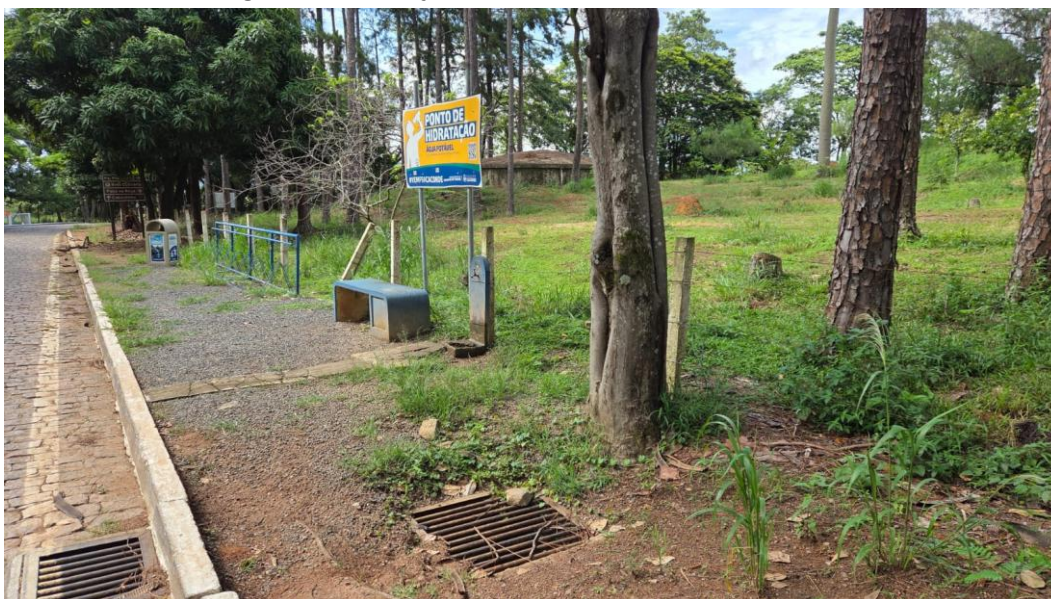
Figura 34 – Situação atual da faixa lateral da estrada.
