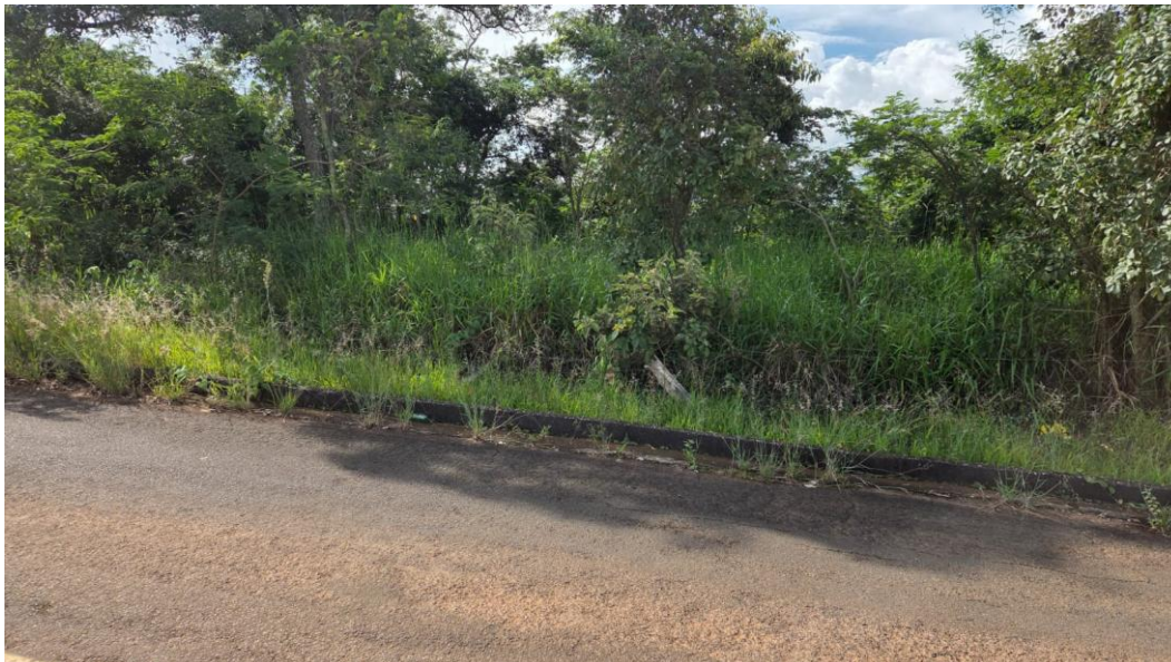
Figura 5 – Situação atual da faixa lateral da estrada.
