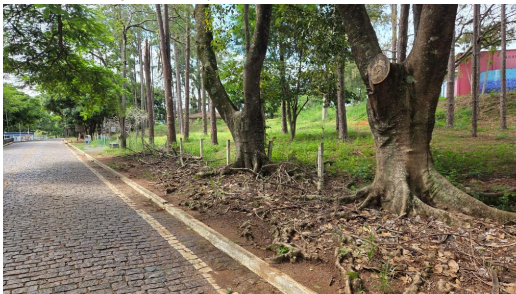
Figura 38 – Situação atual da faixa lateral da estrada.
