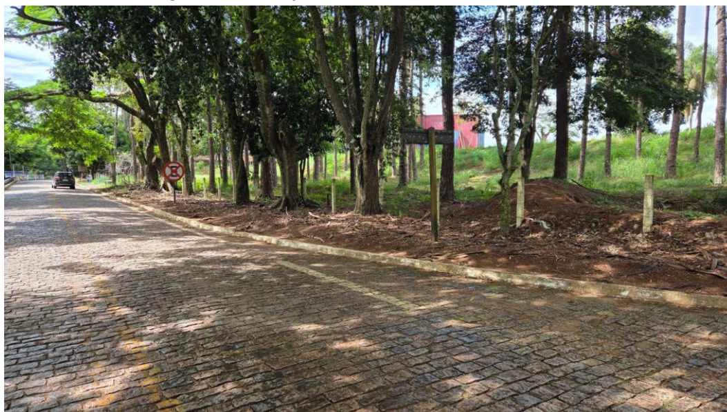
Figura 36 – Situação atual da faixa lateral da estrada.
