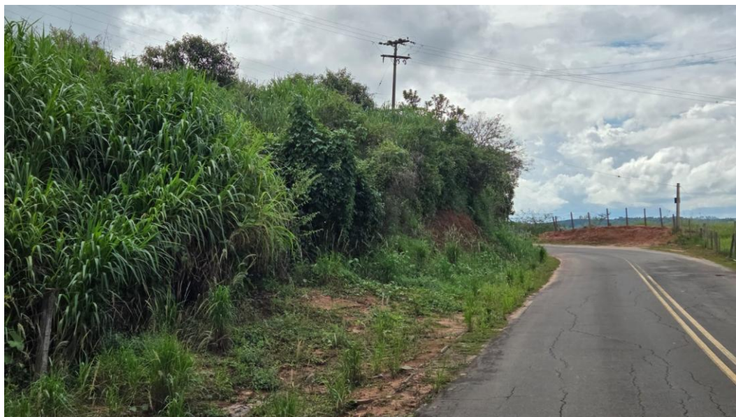
Figura 25 – Situação atual da faixa lateral da estrada.
