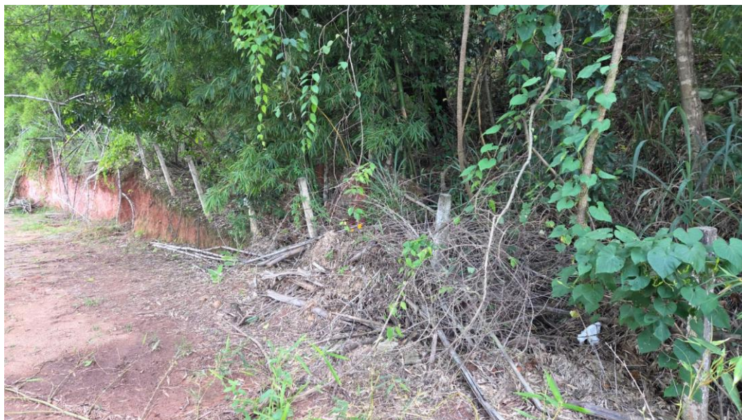
Figura 23 – Situação atual da faixa lateral da estrada.
