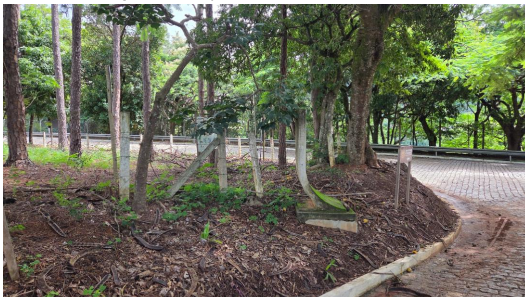
Figura 28 – Situação atual da faixa lateral da estrada.
