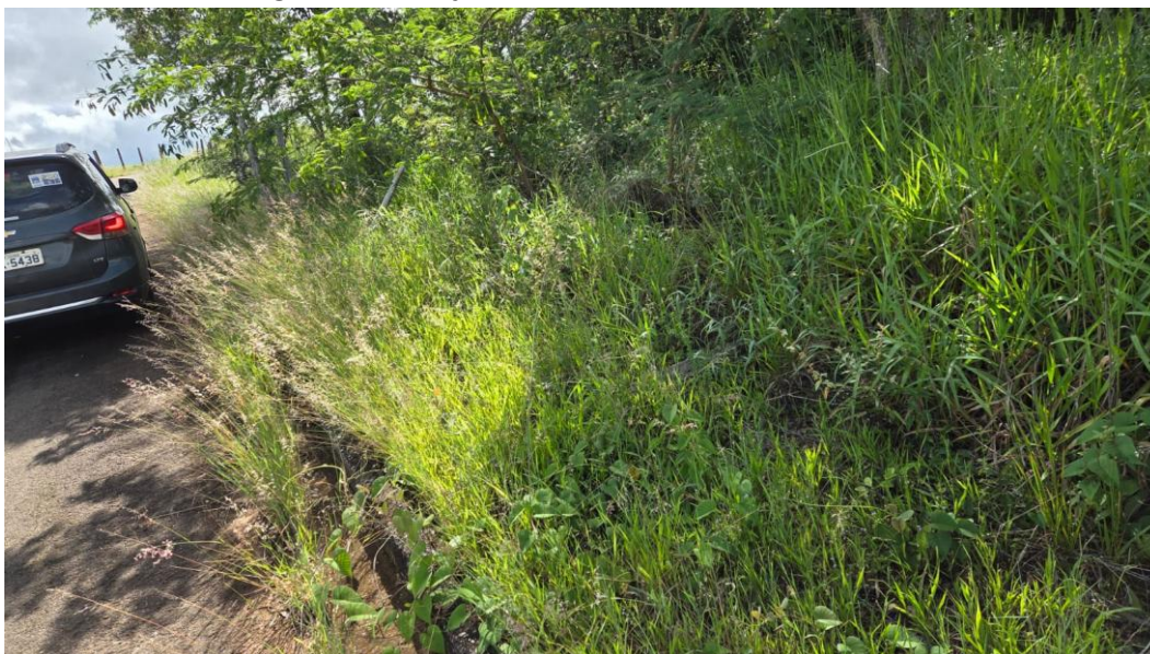
Figura 2 – Situação atual da faixa lateral da estrada.
