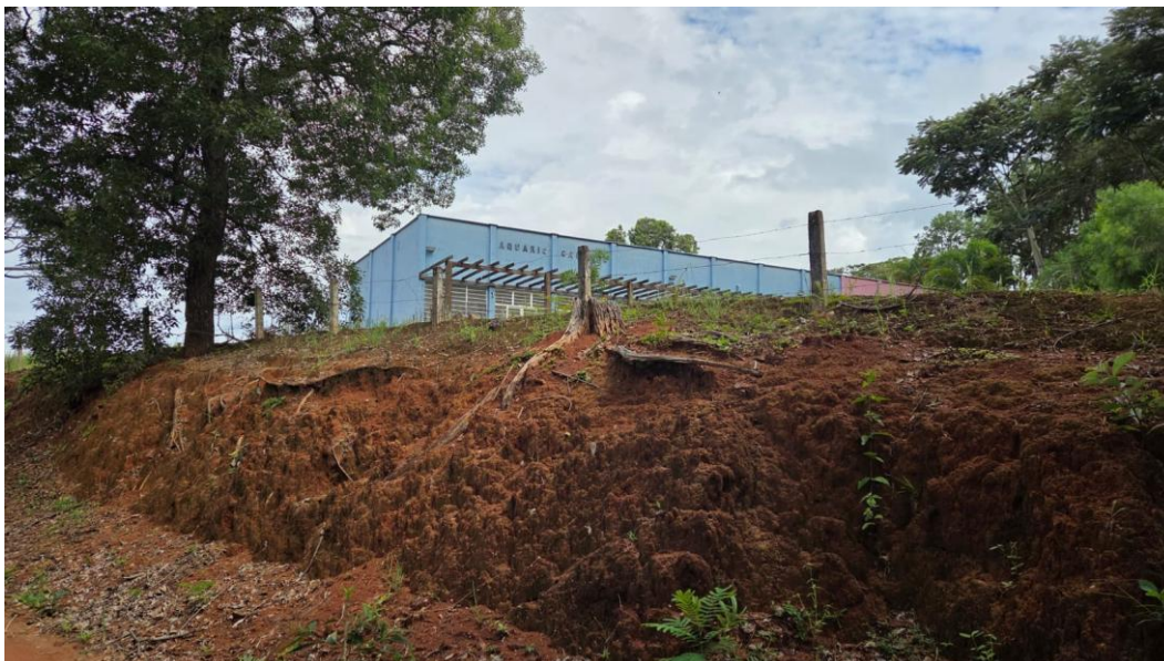
Figura 30 – Situação atual da faixa lateral da estrada.
