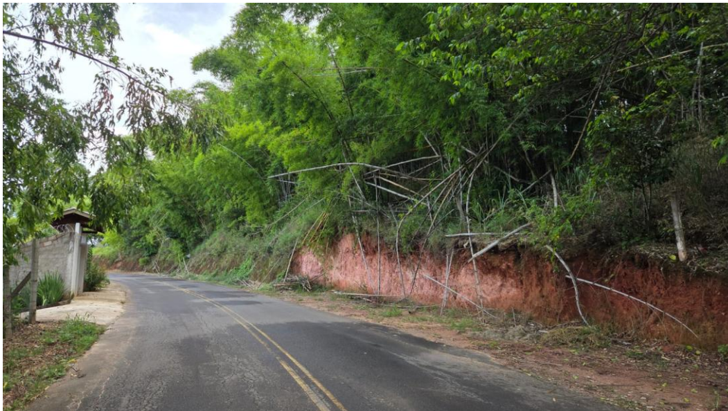
Figura 21 – Situação atual da faixa lateral da estrada.
