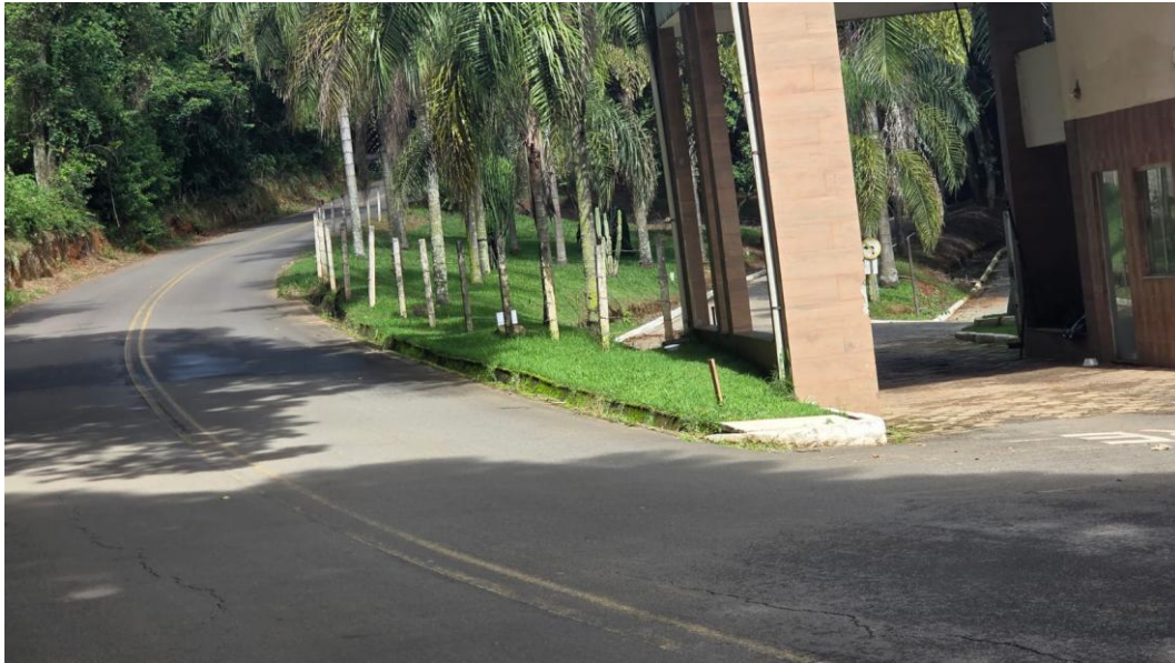
Figura 15 – Situação atual da faixa lateral da estrada.
