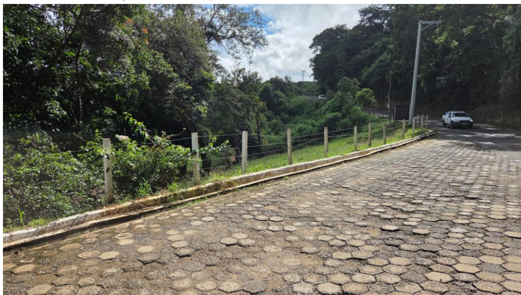
Figura 14 – Situação atual da faixa lateral da estrada.
