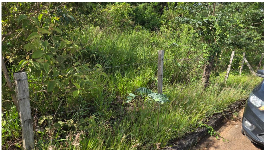
Figura 9 – Situação atual da faixa lateral da estrada.
