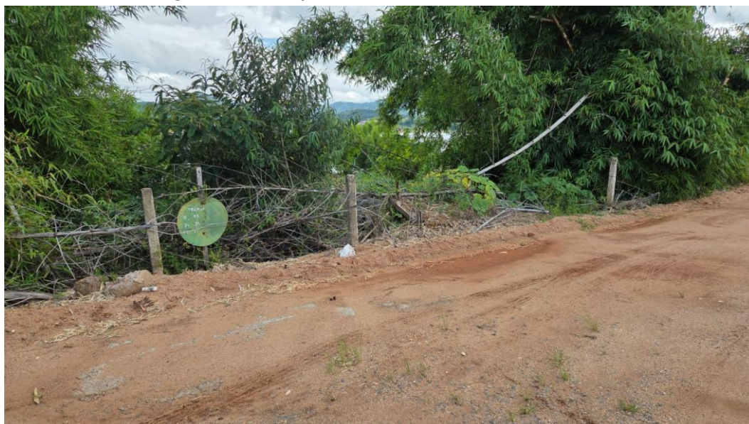
Figura 24 – Situação atual da faixa lateral da estrada.
