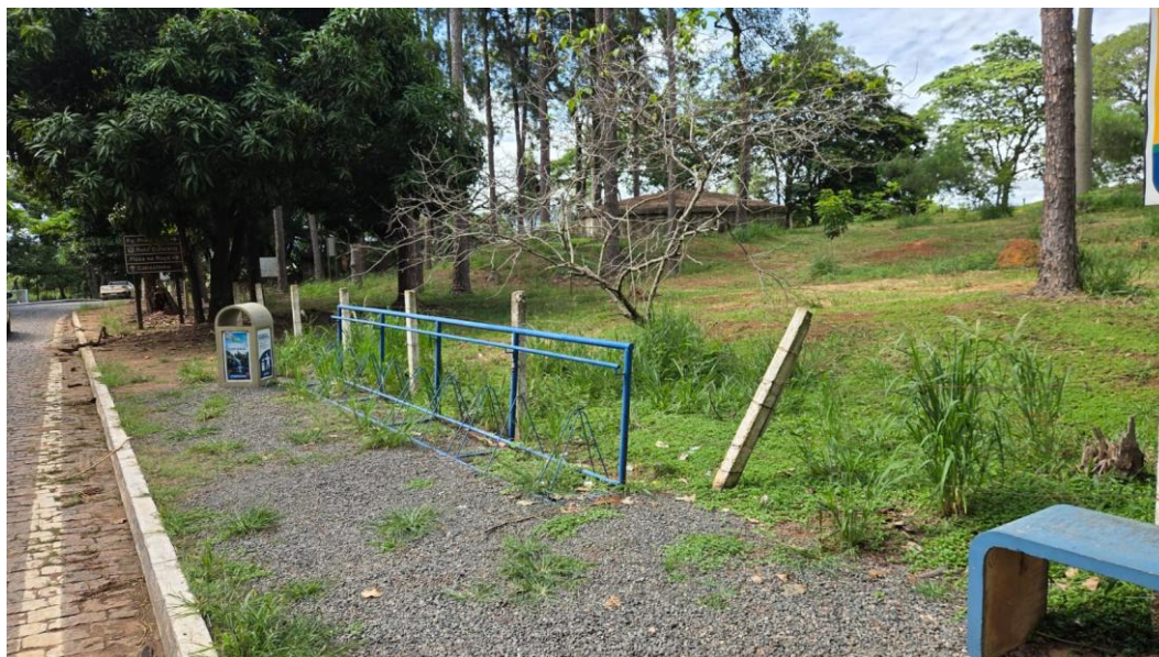
Figura 37 – Situação atual da faixa lateral da estrada.
