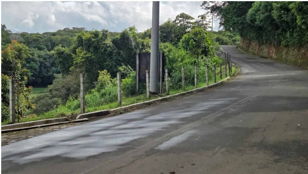
Figura 11 – Situação atual da faixa lateral da estrada.
