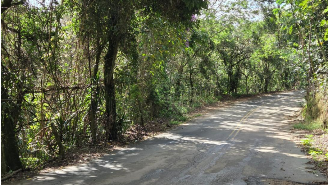
Figura 7 – Situação atual da faixa lateral da estrada.
