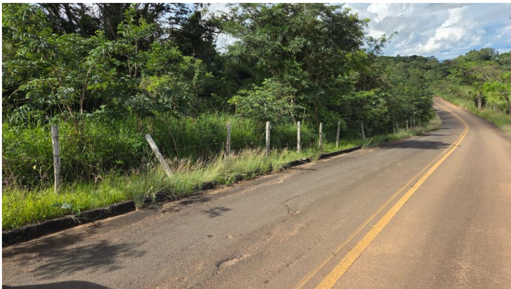
Figura 6 – Situação atual da faixa lateral da estrada.
