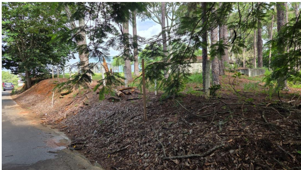
Figura 27 – Situação atual da faixa lateral da estrada.
