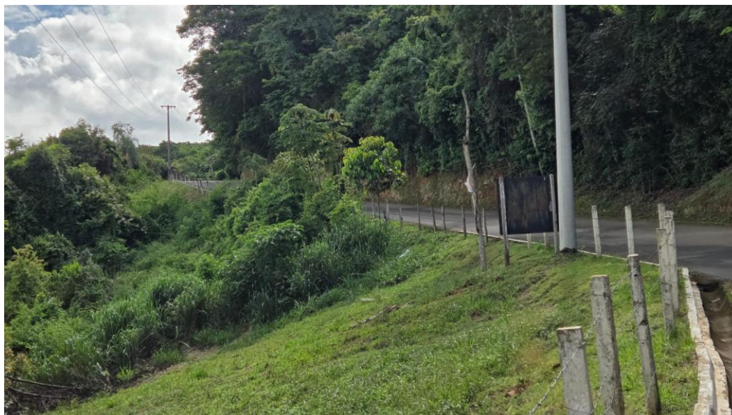
Figura 13 – Situação atual da faixa lateral da estrada.
