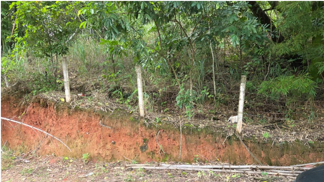
Figura 20 – Situação atual da faixa lateral da estrada.
