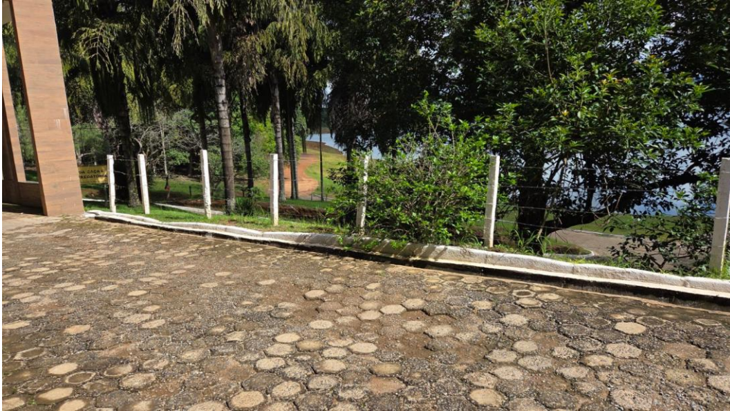
Figura 19 – Situação atual da faixa lateral da estrada.
