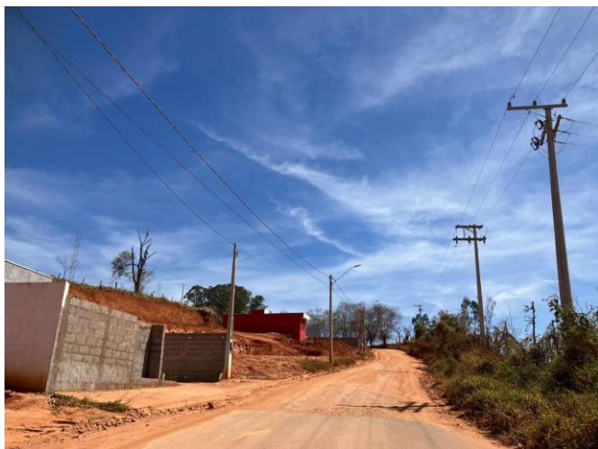
FOTO 01 - INÍCIO DA OBRA
