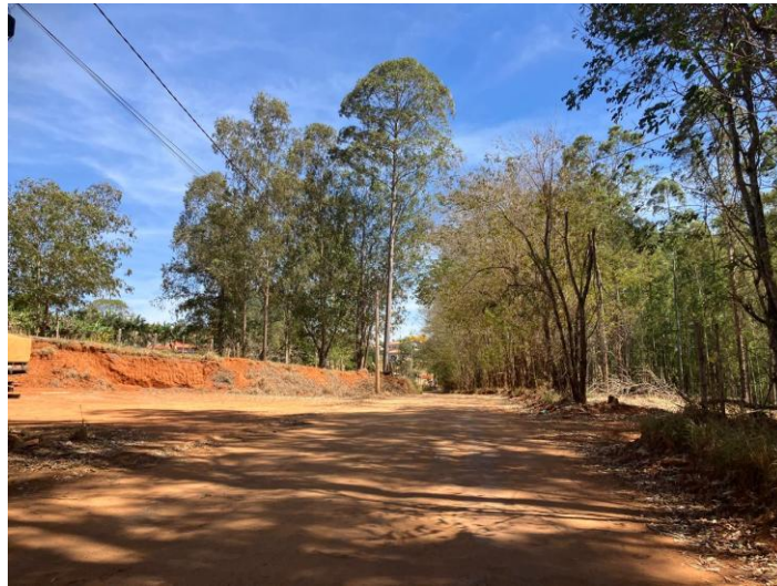
FOTO 05 – TÉRMINO DA OBRA
