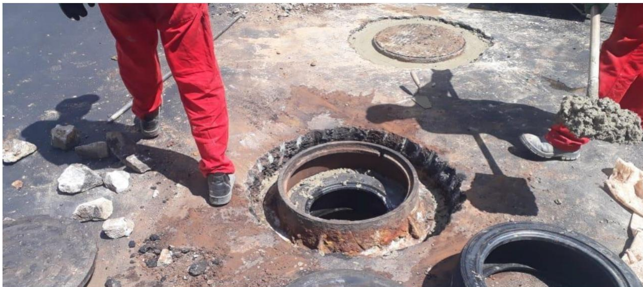
Figura III - Chumbamento do aro do poço de visita com concreto. Ao fundo, outro poço de visita assentado. Fonte: Elaboração SUDECAP – Superintendência de Desenvolvimento de Capital – Prefeitura Municipal de Belo Horizonte – Caderno de Encargos - Drenagem.
