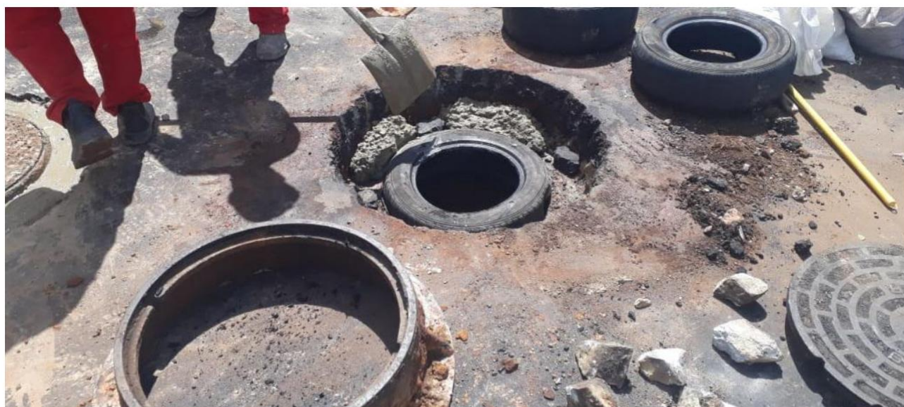
Figura II - Concretagem da base utilizando pneu como forma. Fonte: Elaboração SUDECAP – Superintendência de Desenvolvimento de Capital – Prefeitura Municipal de Belo Horizonte – Caderno de Encargos - Drenagem.
