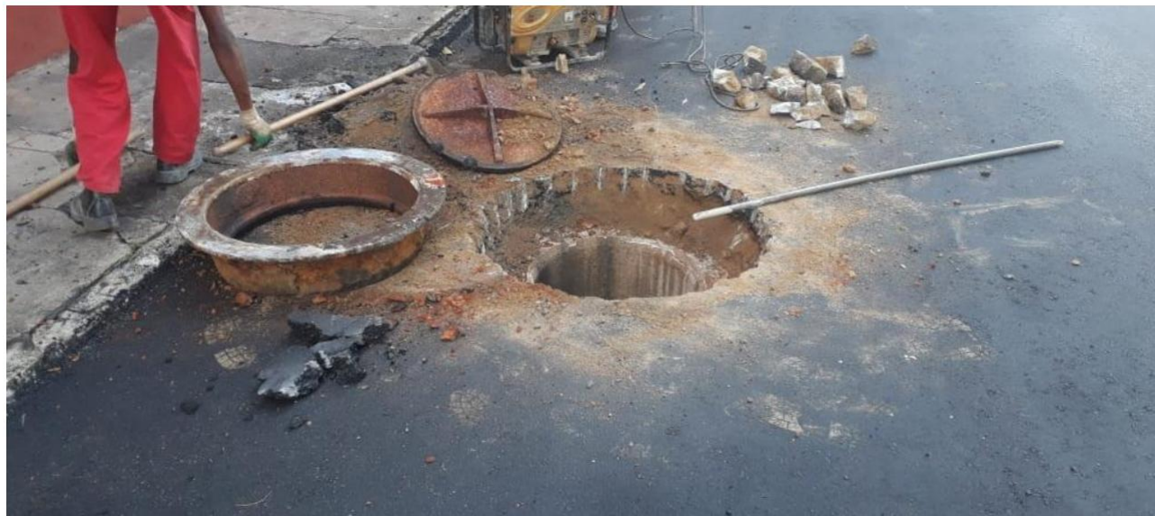
Figura I - Retirada do aro e tampa do poço de visita para alteamento. Fonte: Elaboração SUDECAP – Superintendência de Desenvolvimento de Capital – Prefeitura Municipal de Belo Horizonte – Caderno de Encargos - Drenagem.
