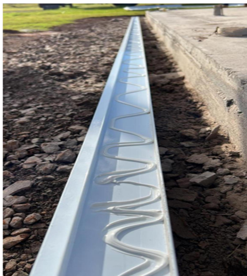
Detalhe de aplicação do adesivo estrutural no perfil tipo “U”
