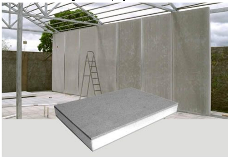
Vista posicionamento painéis de parede no perfil tipo "U"
