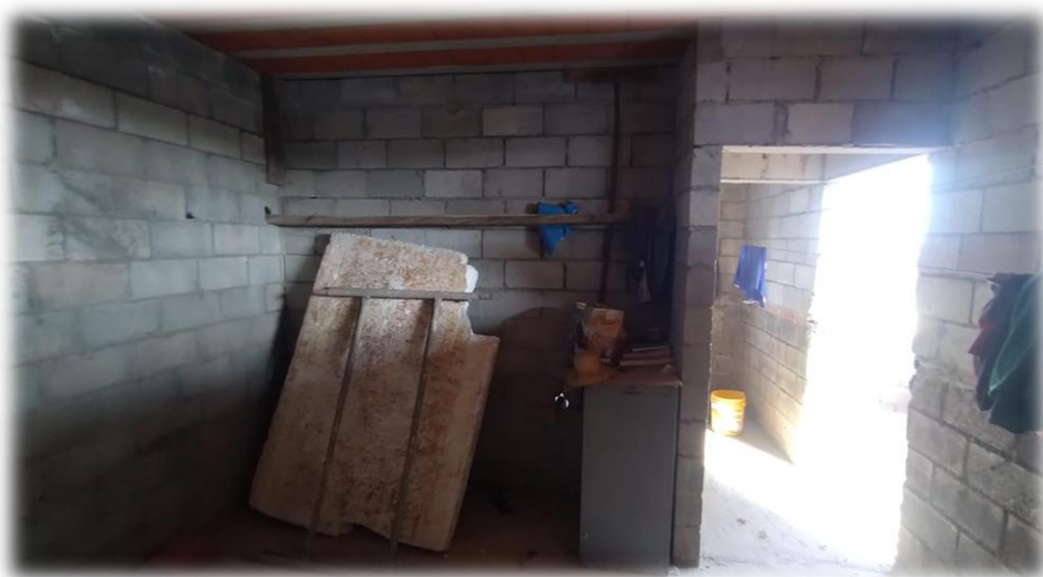
Imagem 05 –vista interna vestiário
