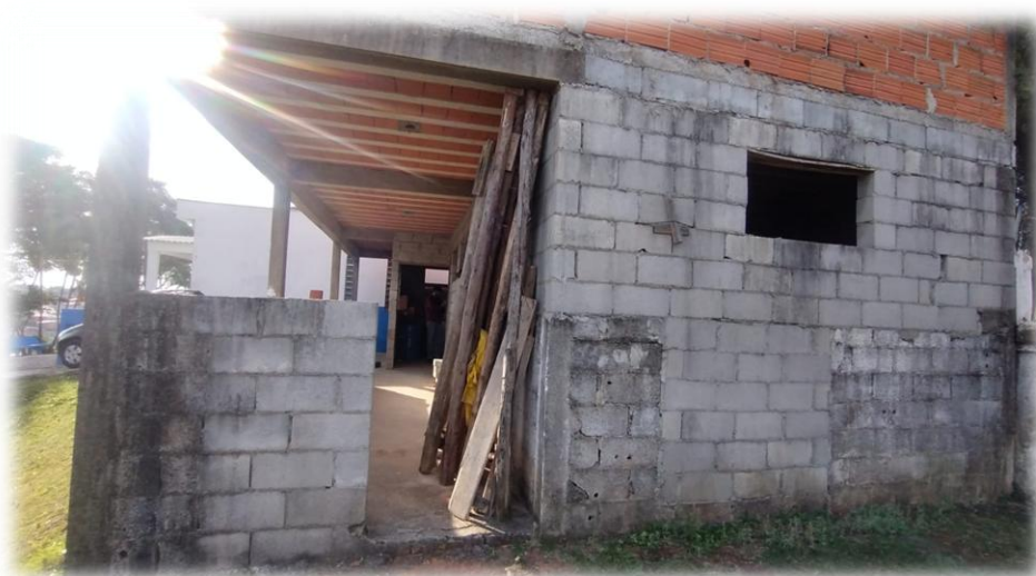
Imagem 04 –vista lateral da edificação/vestiário/cozinha
