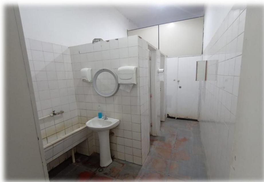
Imagem 07 –vista interna dos banheiros públicos
