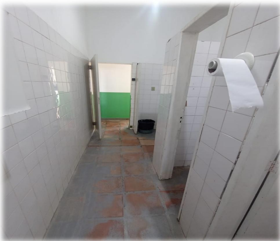
Imagem 08 –vista interna dos banheiros públicos
