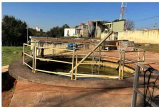
Instalação de ponte raspadora de lodo e motobomba para recalque do lodo para o tanque de lodo.
