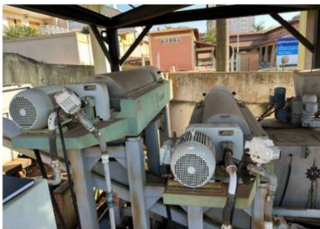
Instalação dos Decanters centrífugos.
