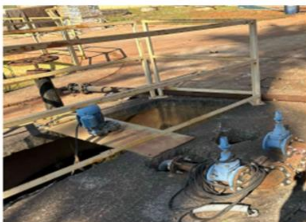
Conferência do agitador e instalação de motobomba.
