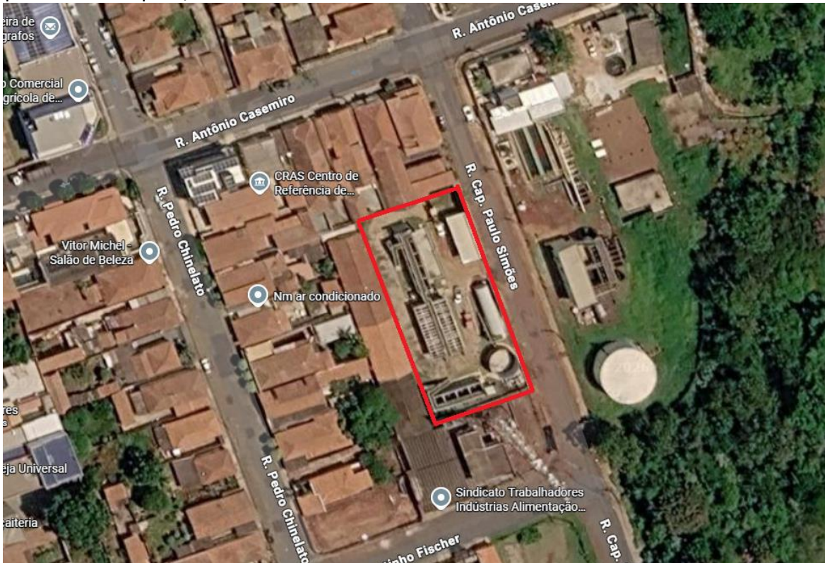
Imagem 01: Localização da ETA Compacta
