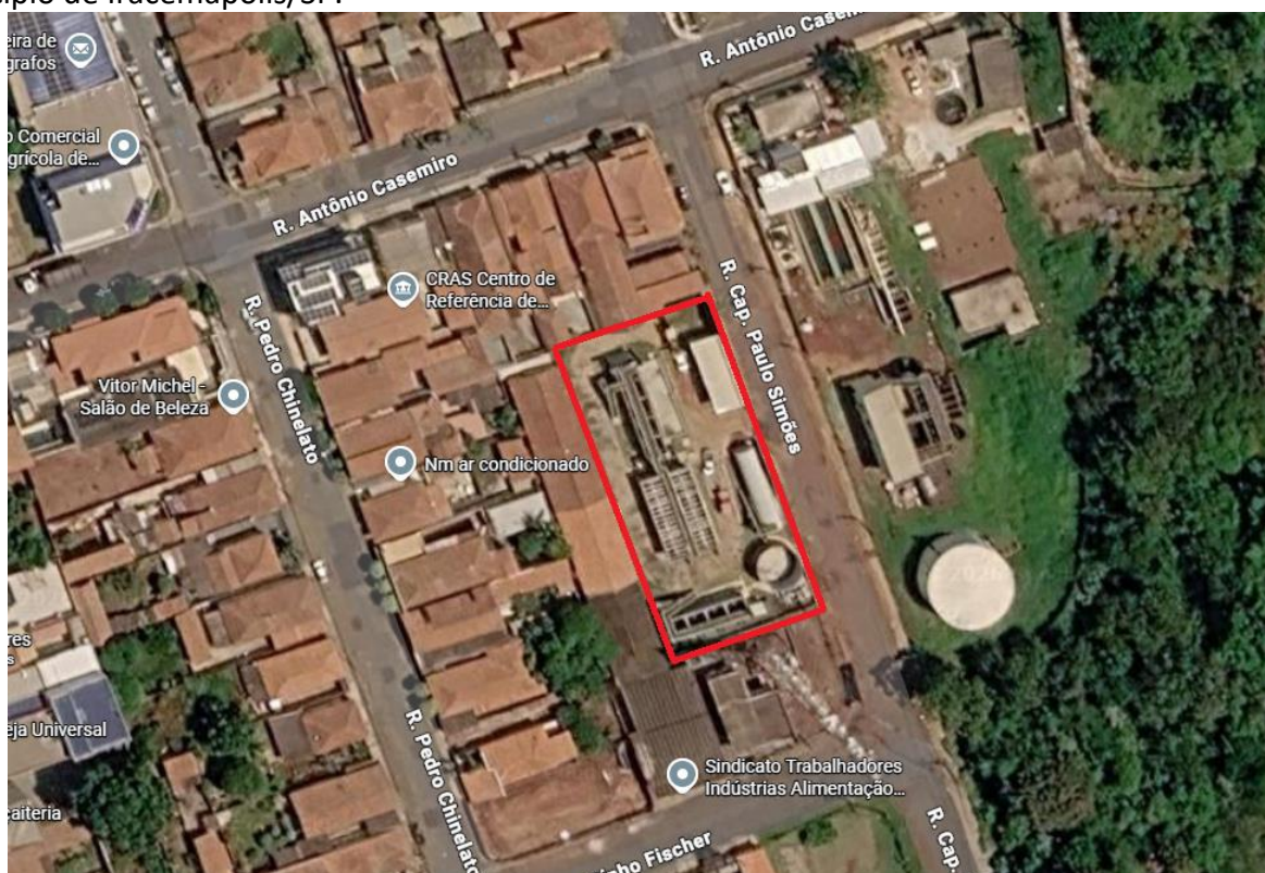
Imagem 01: Localização da ETA Compacta
