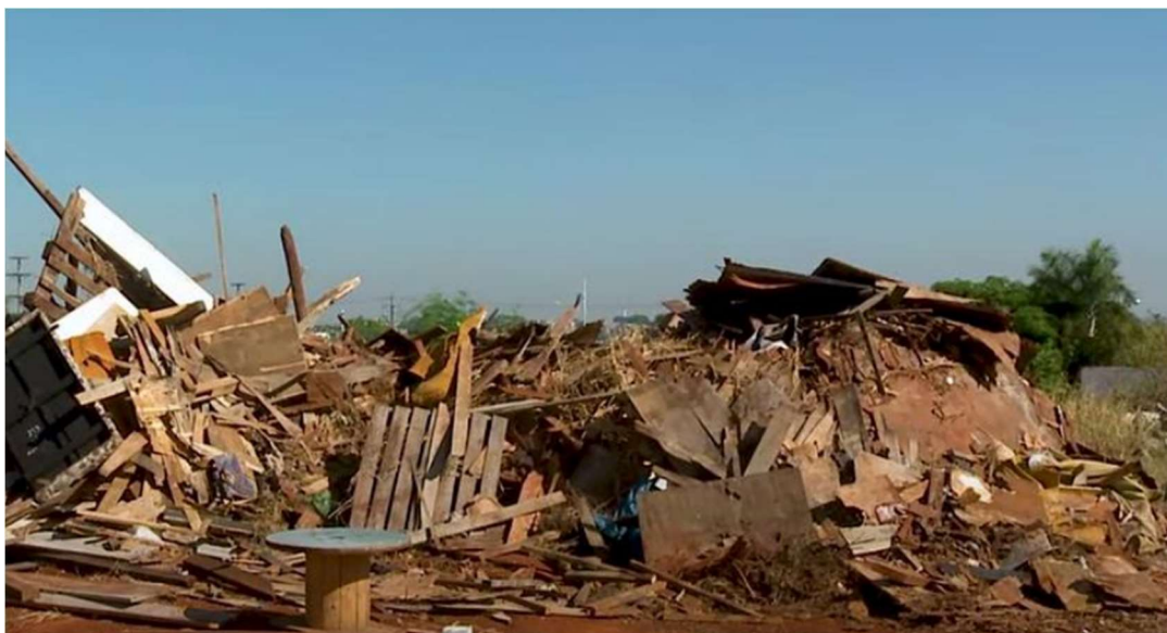
Foto do local de remoção dos resíduos
