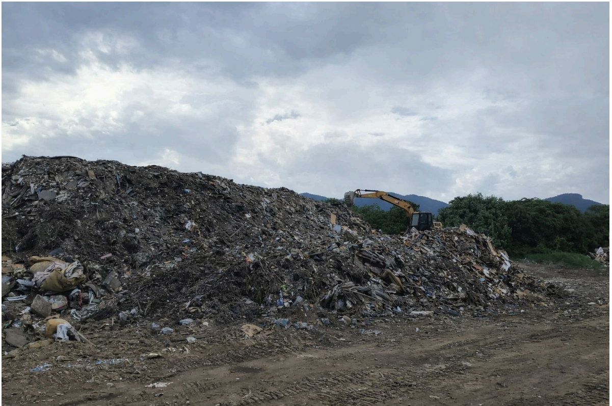
Figura 5: Área de transbordo e triagem de resíduos da construção civil
