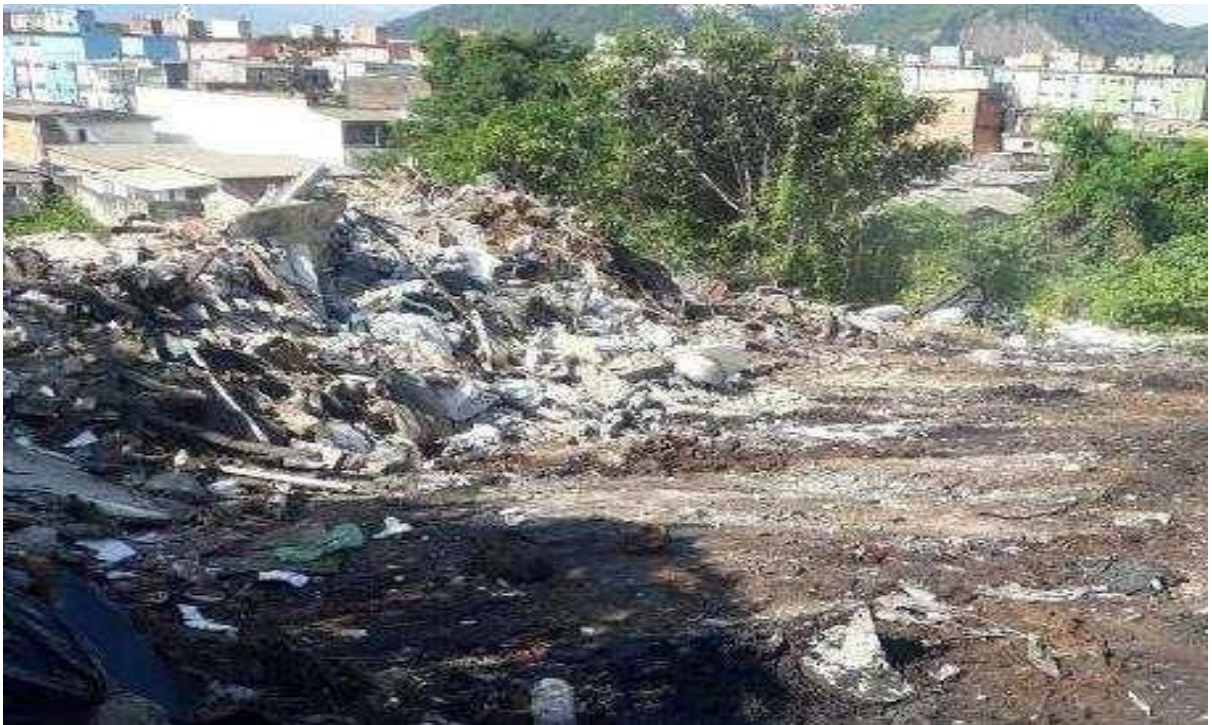
Figura 6: Descarte irregular de resíduos sólidos
