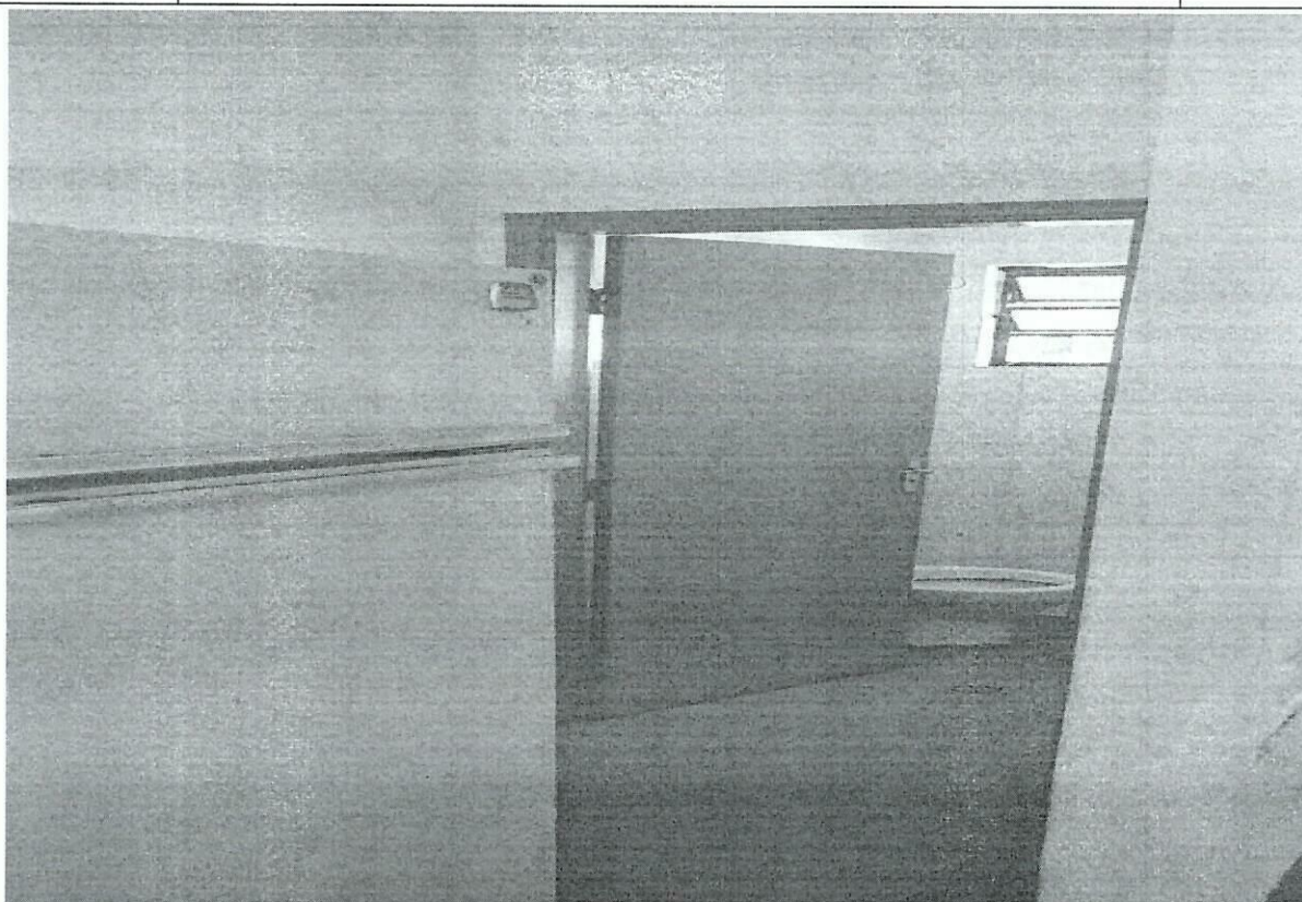
Foto 9 – Local onde será reformado para construir novos sanitários
