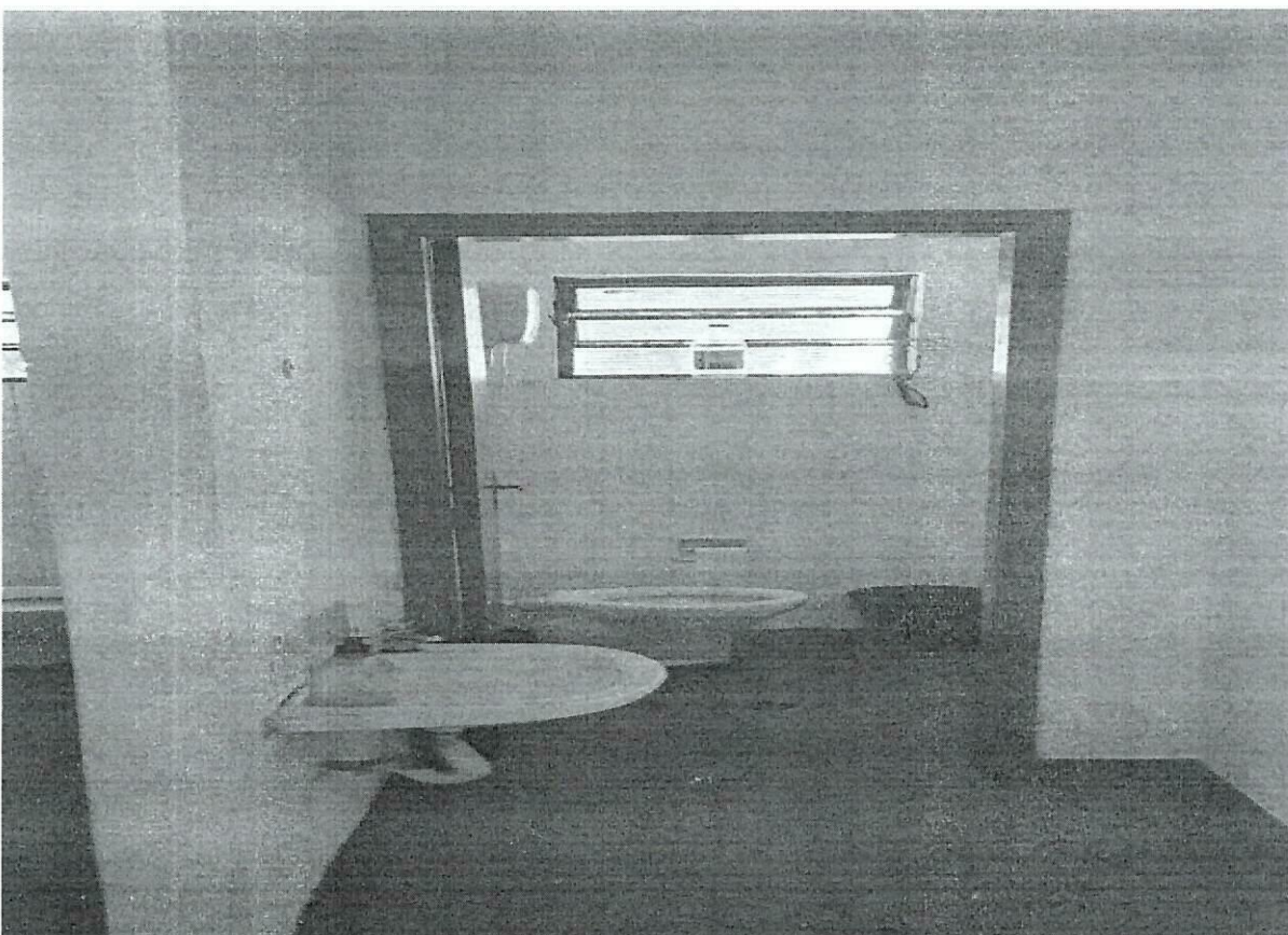
Foto 6 – Sanitários que passarão por reformas e adequações
