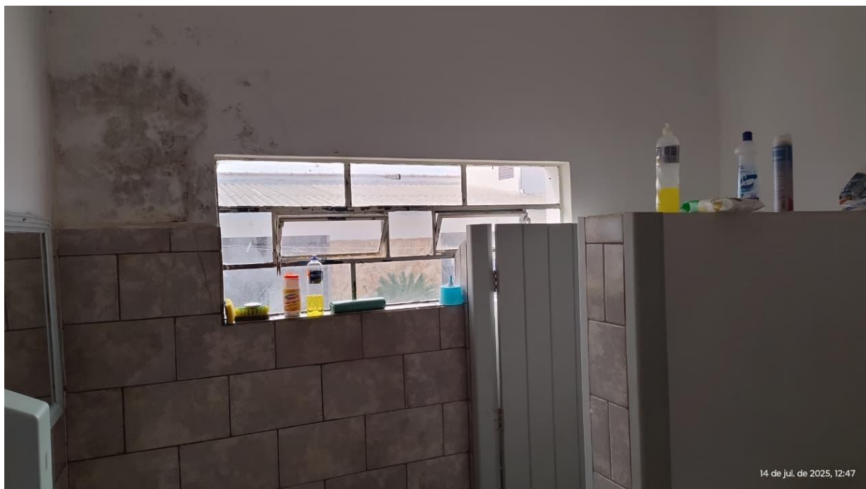
FOTO 7: SANITÁRIOS DOS ALOJAMENTOS SARGENTOS E TENENTES
