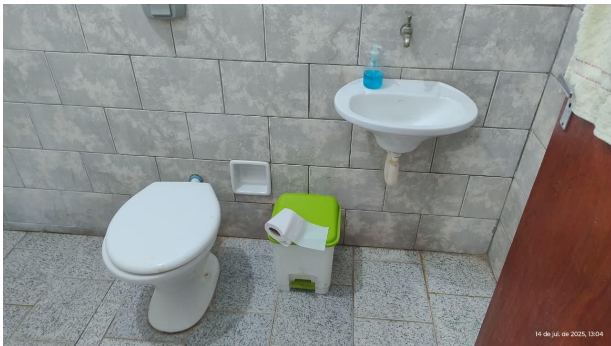
FOTO 9: SANITÁRIO DO ALOJAMENTO FEMININO
