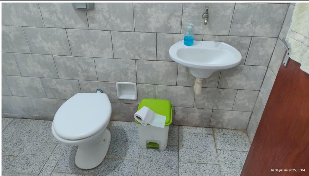
FOTO 11: SANITÁRIO DO ALOJAMENTO FEMININO
