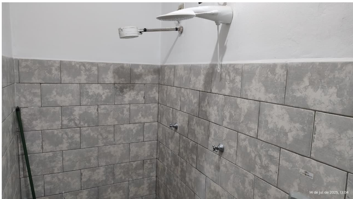
FOTO 10: SANITÁRIO DO ALOJAMENTO FEMININO
