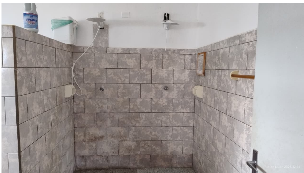
FOTO 8: SANITÁRIOS DOS ALOJAMENTOS SARGENTOS E TENENTES
