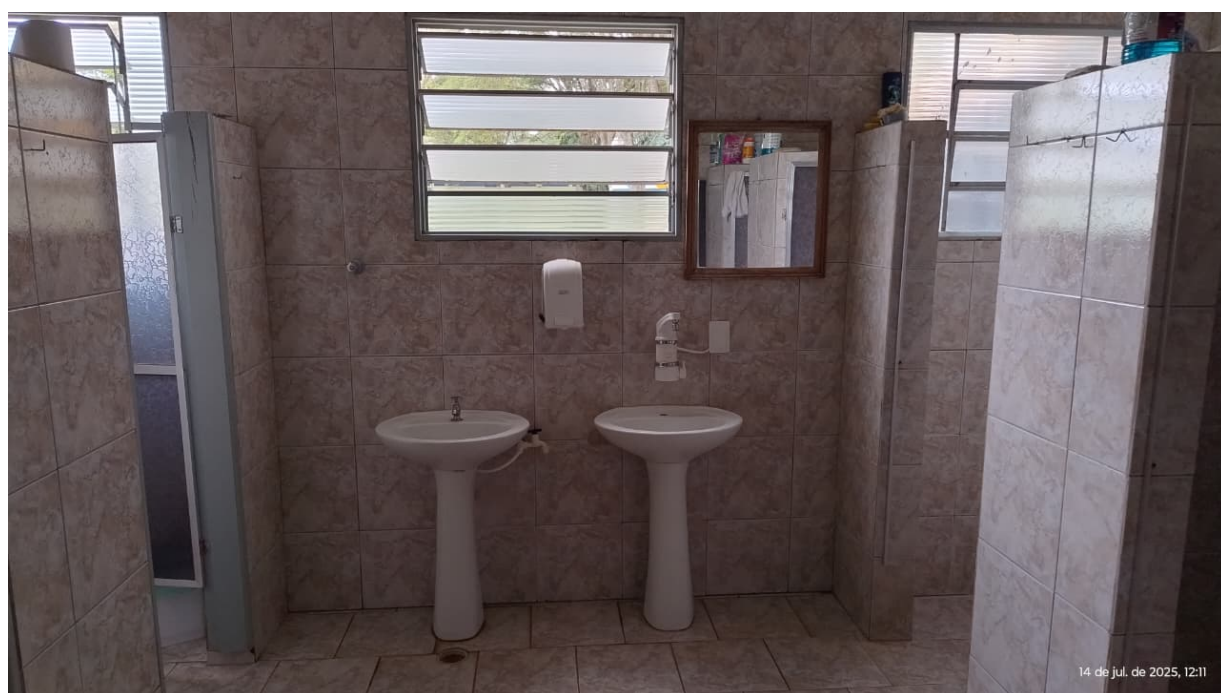
FOTO 2: SANITÁRIOS DOS ALOJAMENTOS CABOS E SOLDADOS
