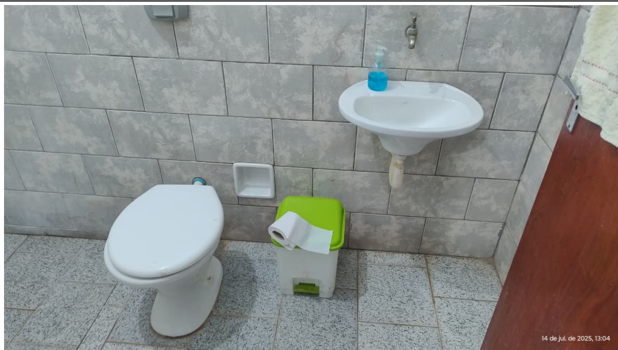
FOTO 11: SANITÁRIO DO ALOJAMENTO FEMININO
