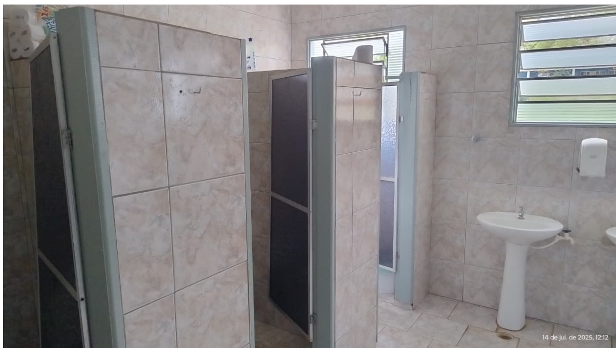
FOTO 4: SANITÁRIOS DOS ALOJAMENTOS CABOS E SOLDADOS
