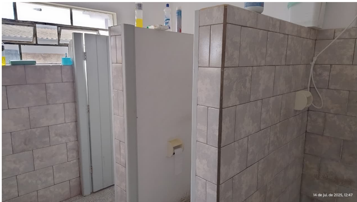
FOTO 6: SANITÁRIOS DOS ALOJAMENTOS SARGENTOS E TENENTES
