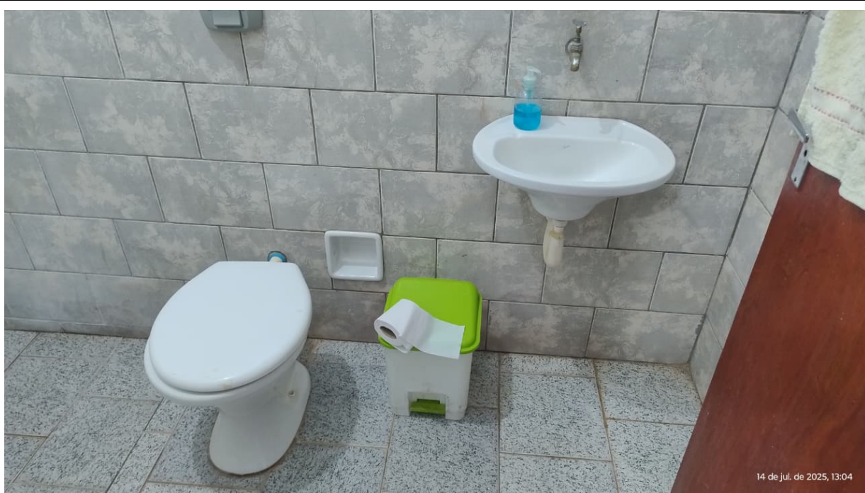
FOTO 9: SANITÁRIO DO ALOJAMENTO FEMININO
