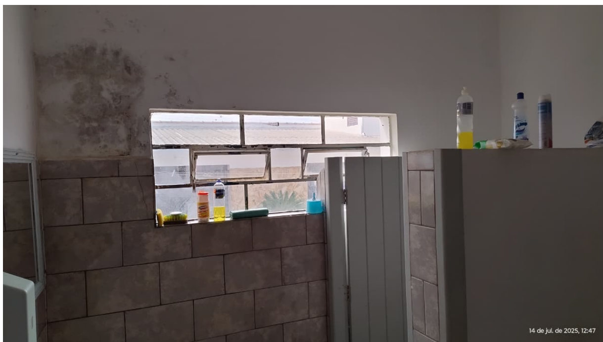
FOTO 7: SANITÁRIOS DOS ALOJAMENTOS SARGENTOS E TENENTES
