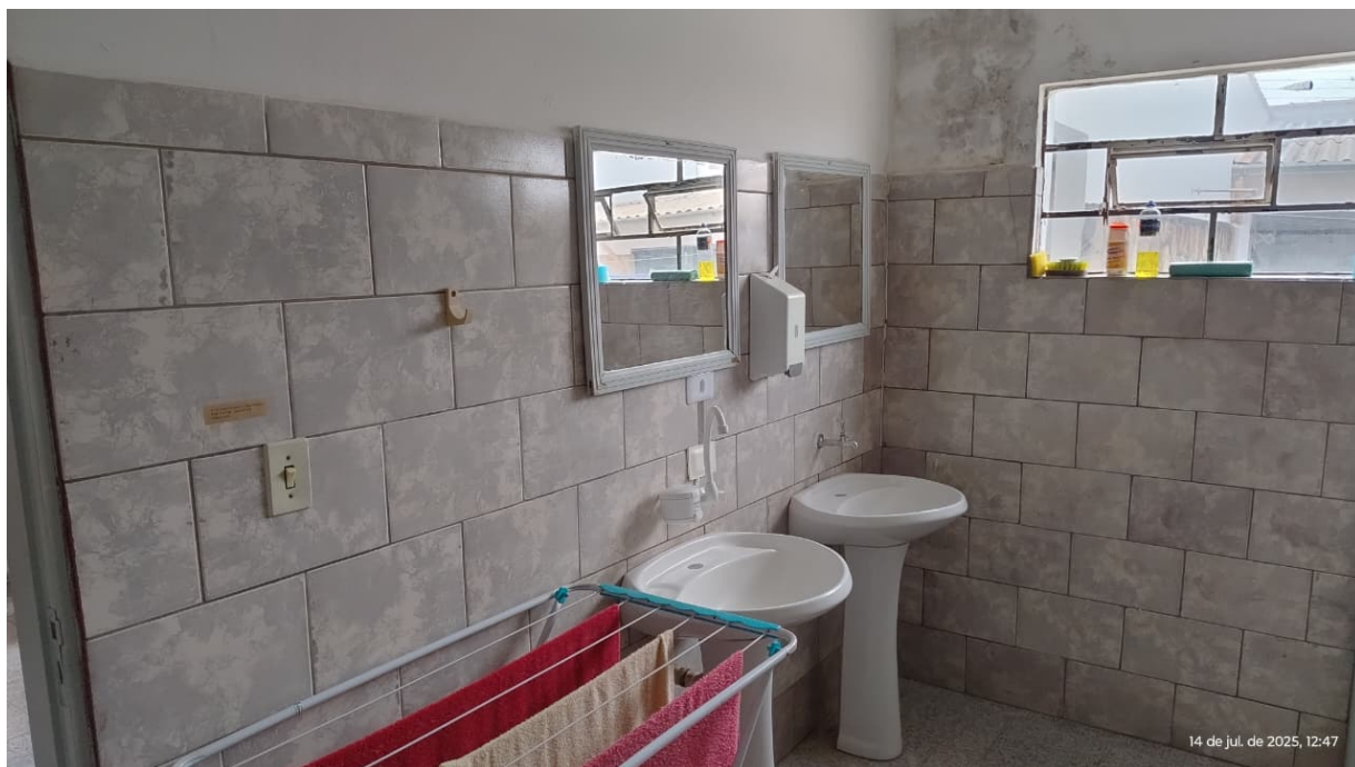
FOTO 5: SANITÁRIOS DOS ALOJAMENTOS SARGENTOS E TENENTES
