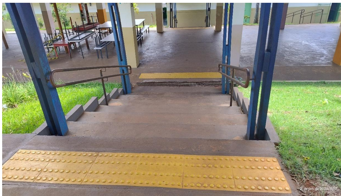
Foto 7 - Vista escada de acesso passagem coberta 01
