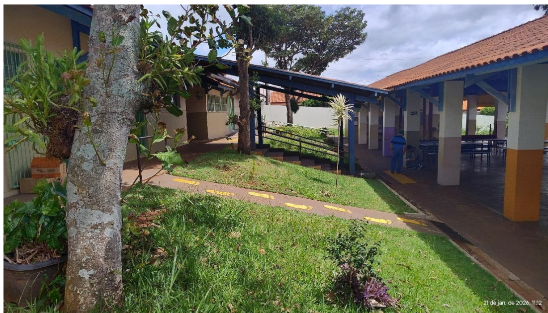
Foto 5 - Vista passagem coberta 01
