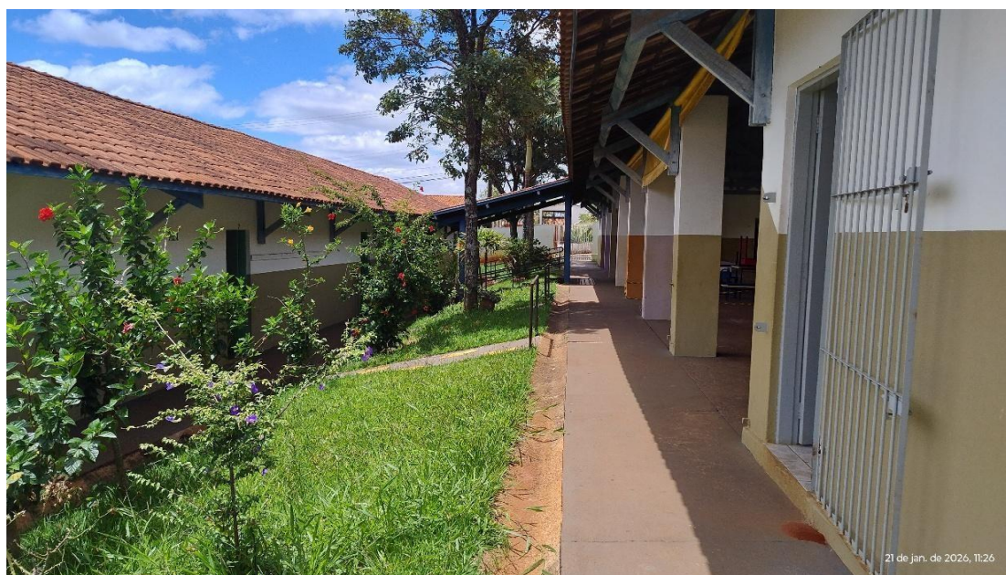
Foto 10 - Vista lateral e passagem coberta 02
