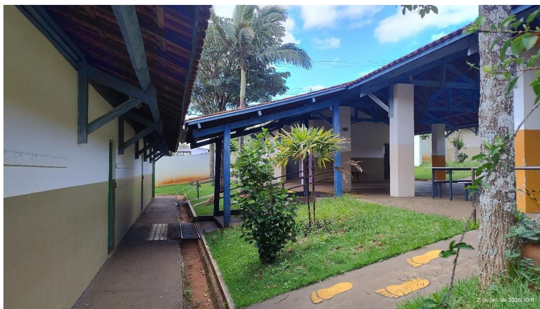
Foto 4 - Vista passagem coberta 02
