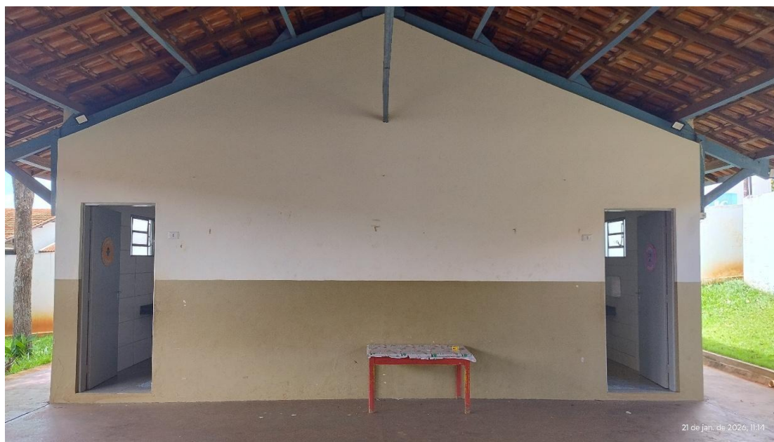
Foto 9 - Vista cobertura dos sanitários
