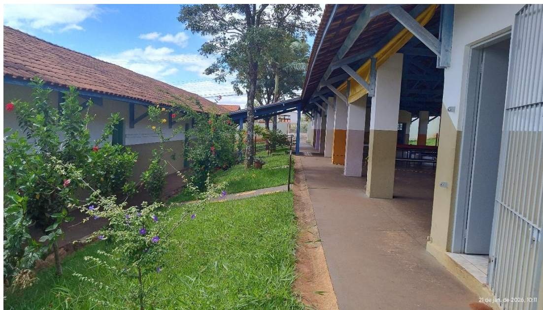
Foto 3 - Vista externa cobertura patio/refeitório
