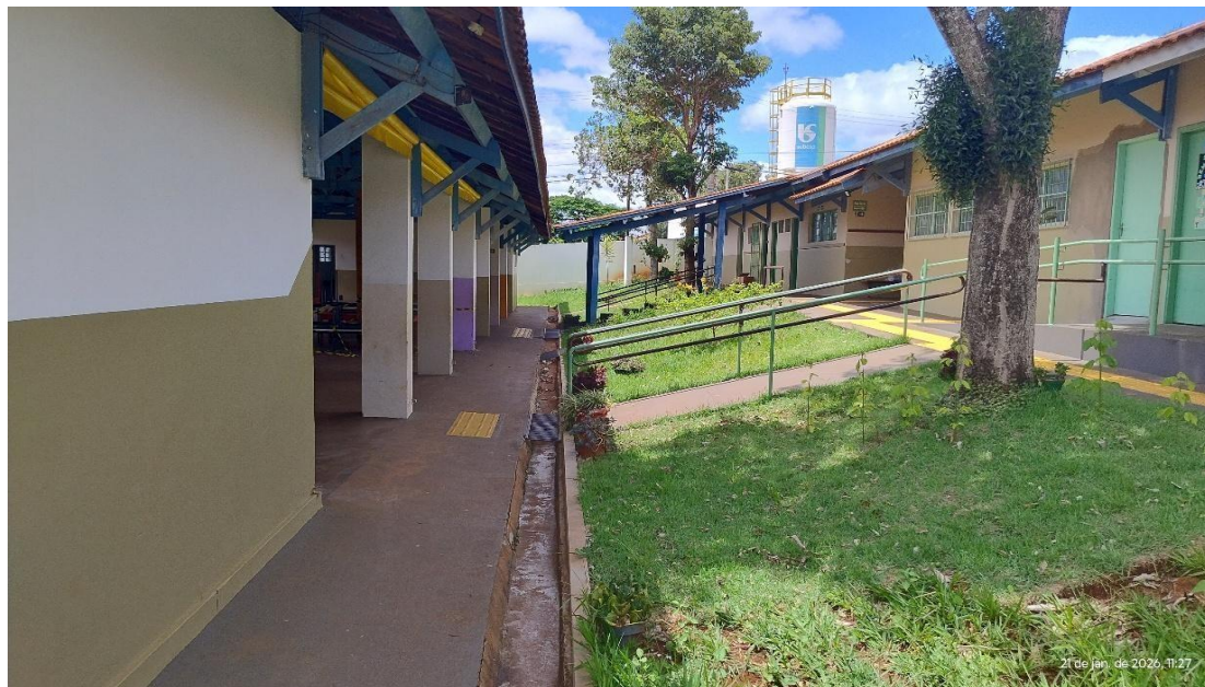
Foto 11 - Vista lateral e passagem coberta 01
