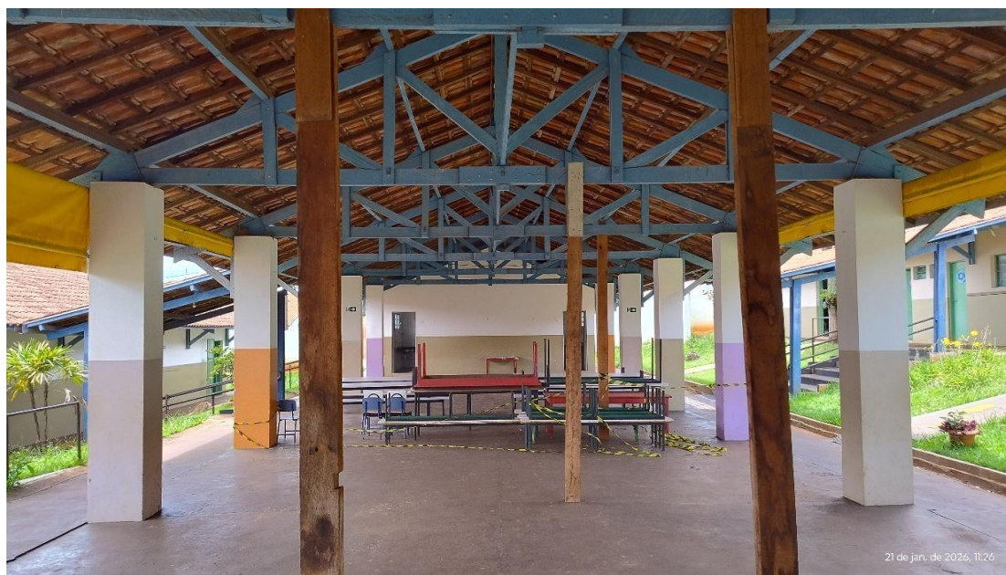
Foto 2 - Vista interna cobertura patio/refeitório
