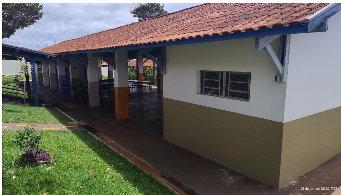
Foto 8 - Vista lateral cobertura
