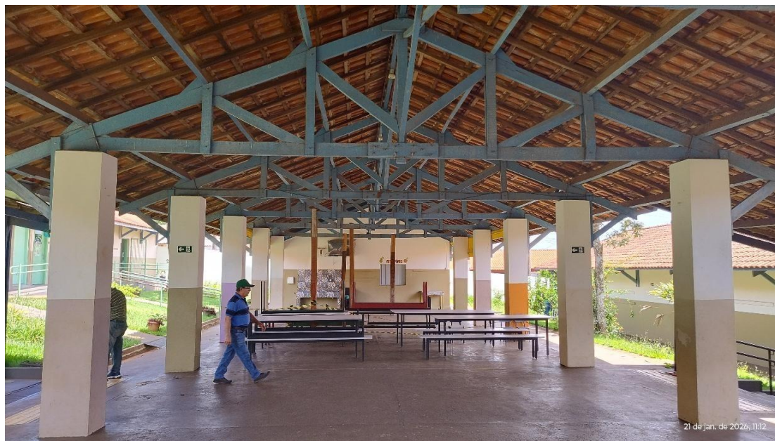
Foto 1 - Vista interna cobertura patio/refeitório
