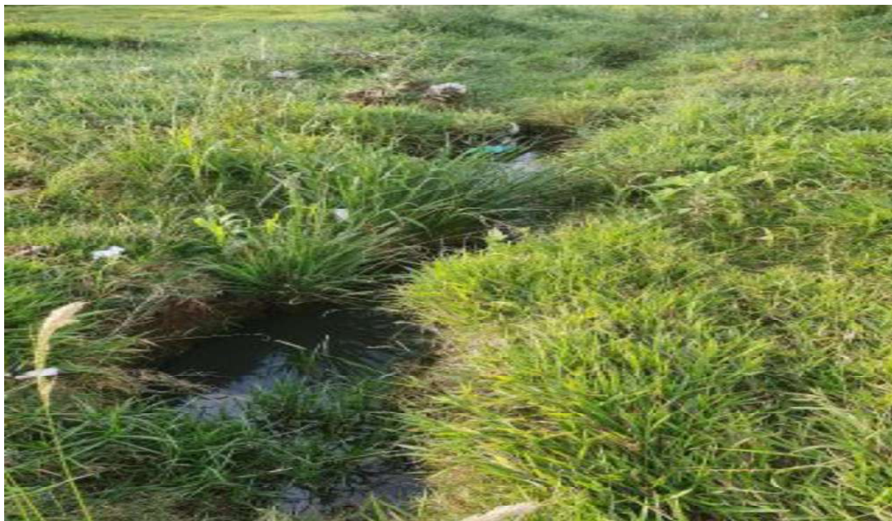
Imagem do processo erosivo.
