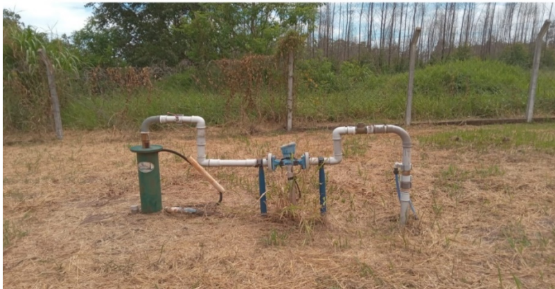
Figura 4.7. Cavalete do Poço Itaquerí da Serra
