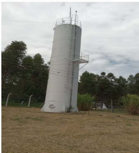
Reservatório Metálico 60 m3
