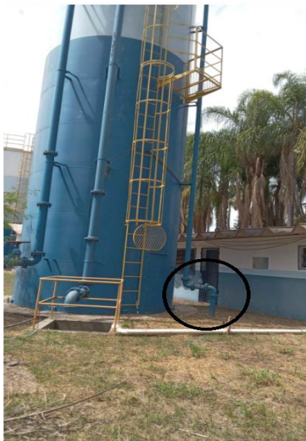
Figura 4.4. Entrada reservatório apoiado
