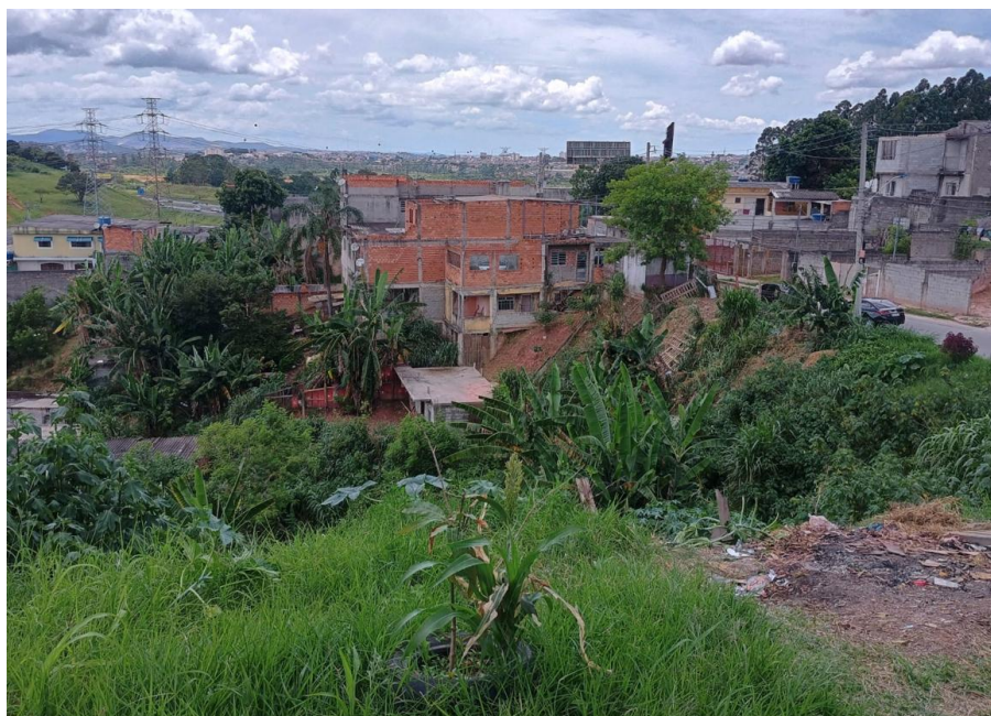
Figura 5 – Vista geral do local a ser implantado o muro de contenção
