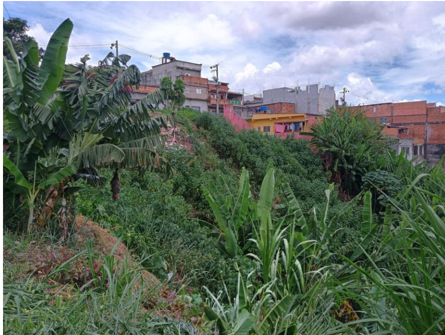
Figura 4 – Vista geral do local a ser implantado o muro de contenção
