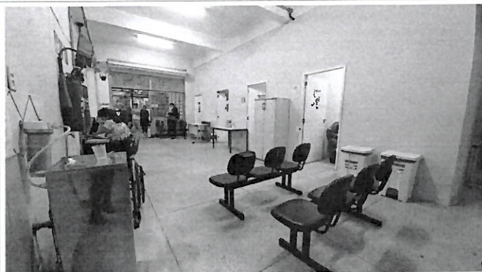
Foto 05 – aspecto geral do pavimento térreo
