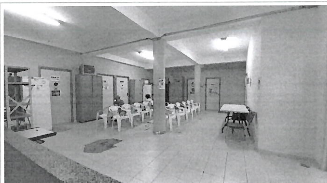
Foto 20 – aspecto geral do pavimento superior
