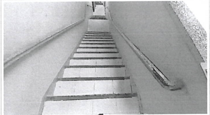
Foto 19 – escada de acesso ao pavimento superior
