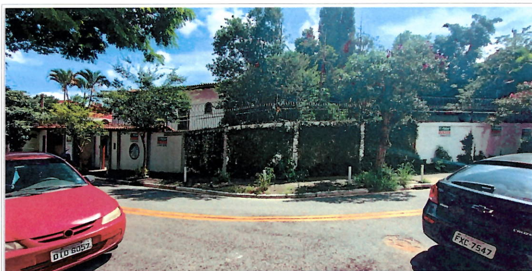
Fotos 01 – fachada do imóvel
