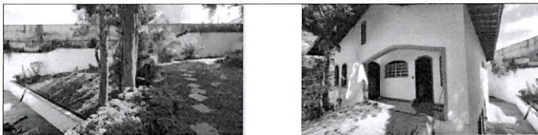
Fotos 16 e 17 –jardim e fachada do imóvel (pavimento superior)
