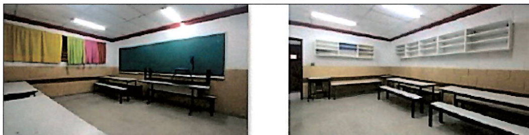
Fotos 32 e 33 – pavimento inferior - salas
