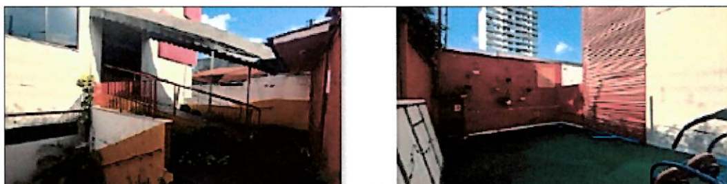
Fotos 52 e 53 – pavimento inferior- área externa
