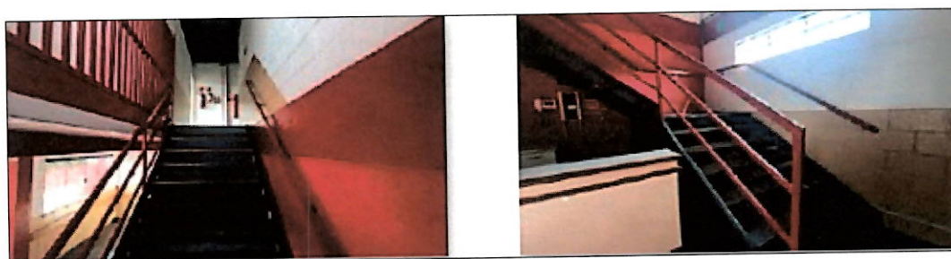
Fotos 04 e 05 – escada de acesso ao pavimento superior (quadra)
