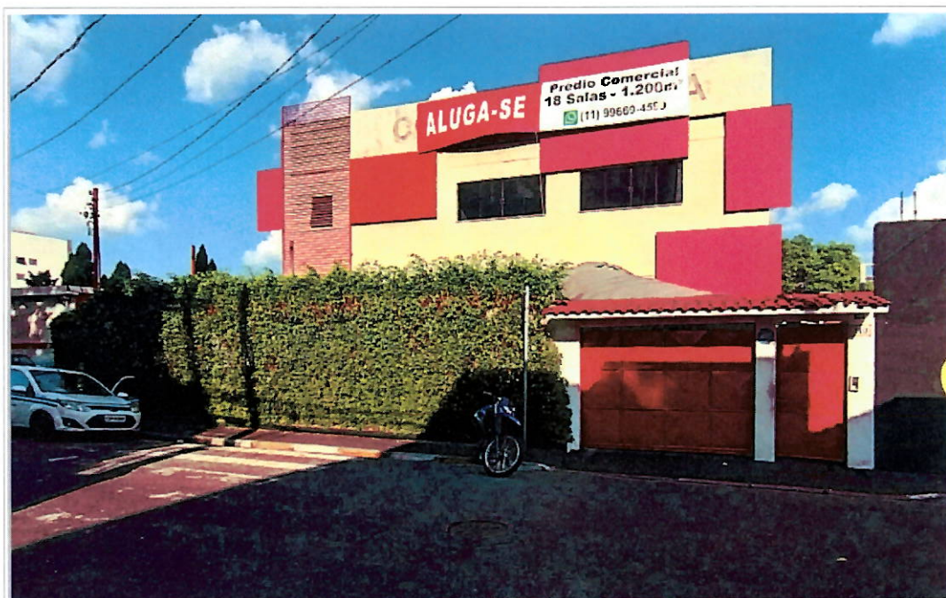
Fotos 01 – fachada do imóvel
