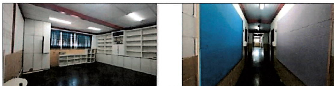
Fotos 20 e 21 – piso em ardósia
