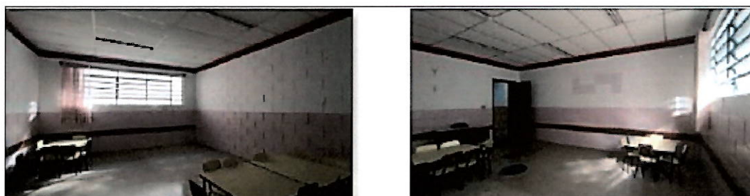
Fotos 40 e 41 – pavimento inferior-sala
