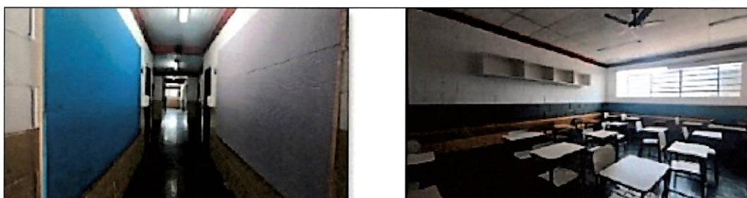
Fotos 16 e 17 – pavimento térreo (aspecto geral das salas)
