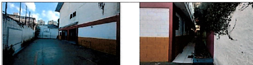
Fotos 36 e 37 – – pavimento inferior -circulação e área externa aos fundos (quadra)
