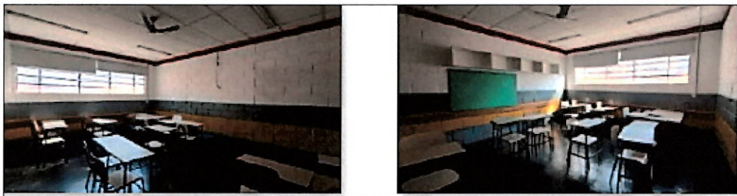
Fotos 22 e 23 – salas: pintura sobre blocos, forro em gesso e piso em ardósia
