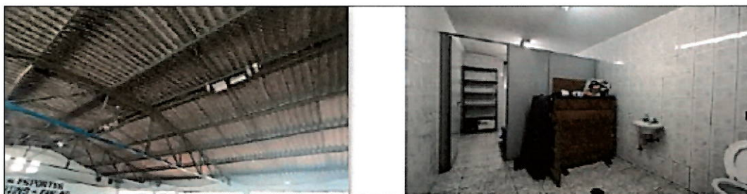
Fotos 08 e 09 – cobertura da quadra e aspecto geral do sanitário
