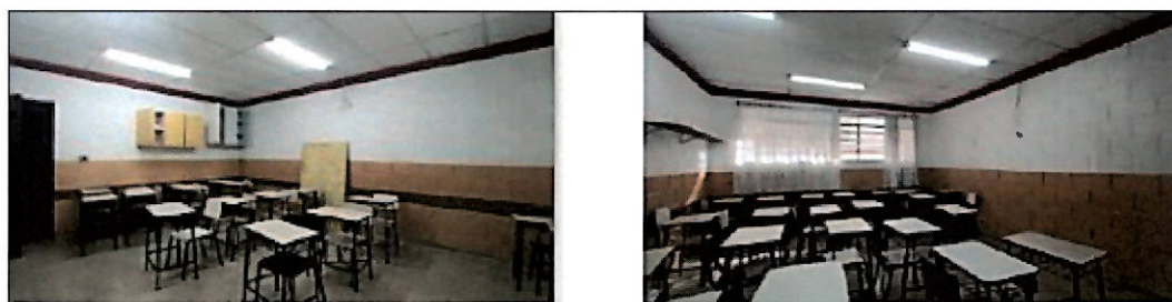
Fotos 42 e 43 – pavimento inferior - sala
