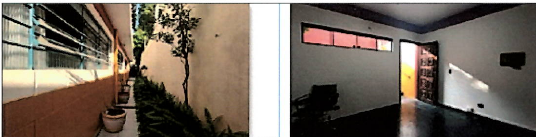
Fotos 48 e 49 – pavimento inferior – área lateral e sala
