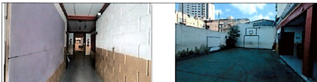
Fotos 34 e 35 – pavimento inferior -circulação e área externa aos fundos (quadra)
