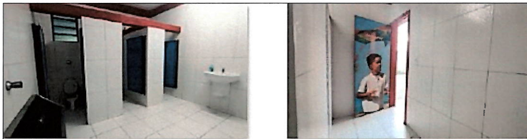
Fotos 30 e 31 – sanitários
