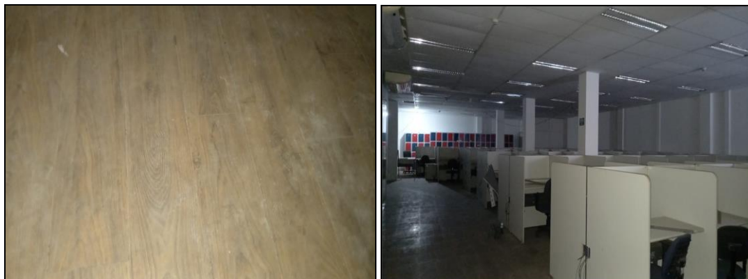
Fotos 42 e 43 – piso de vinílico/sala de trabalho na área térrea
