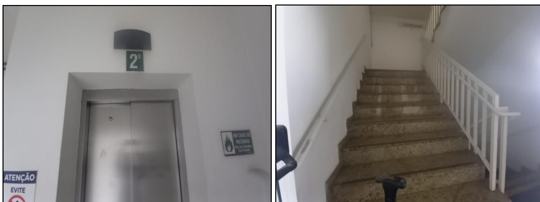
Fotos 26 e 27 – elevador/escada do 2º andar
