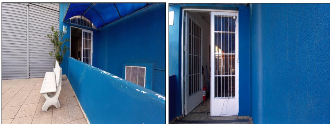
Fotos 64 e 65 – entrada do equipamento
