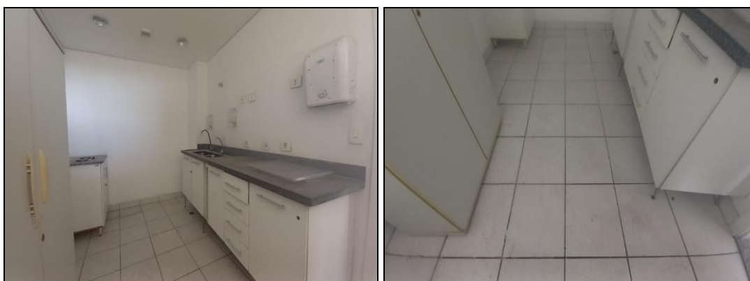
Fotos 46 e 47 – copa/piso cerâmico 3º andar
