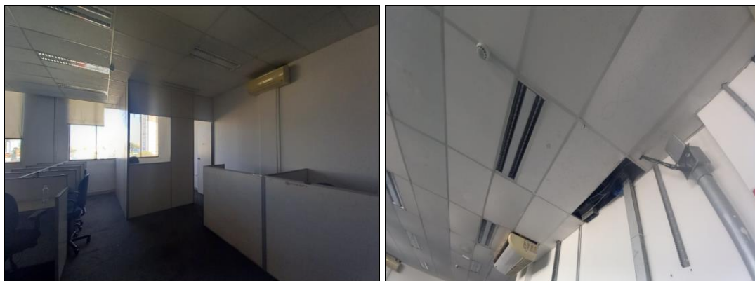
Fotos 30 e 31 – sala de trabalho/ ar condicionado 2º andar
