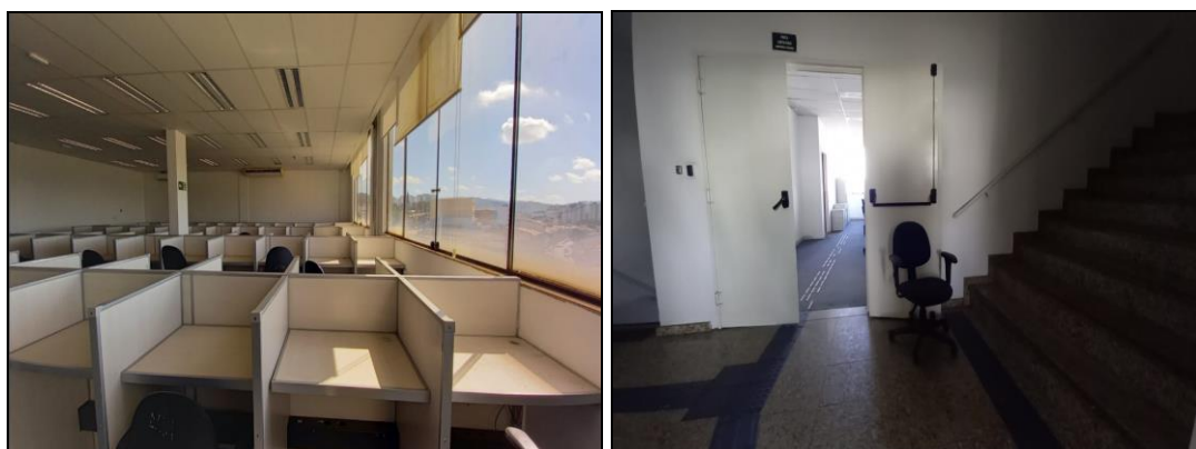
Fotos 52 e 53 – sala administrativa/escada para a cobertura
