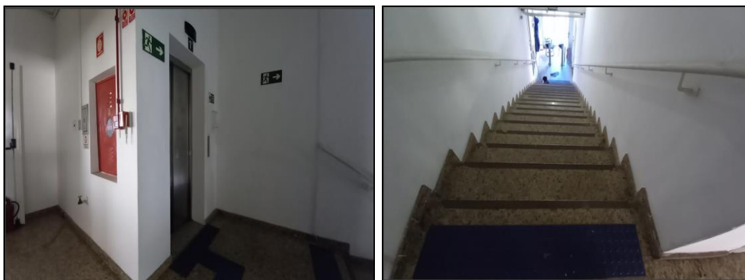
Fotos 02 e 03 – elevador / escada do 1º andar
