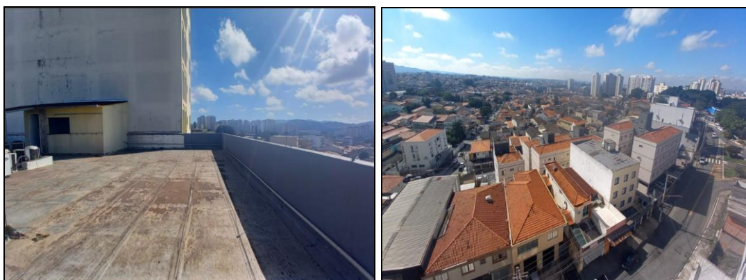
Fotos 62 e 63- cobertura
