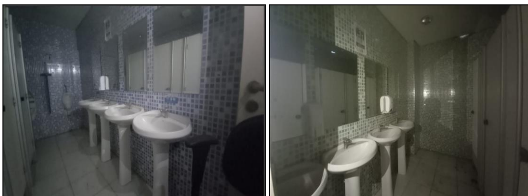
Fotos 32 e 33 – banheiro masculino /feminino 2º andar
