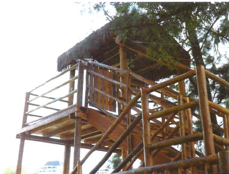
Estrutura da Tirolesa Existente
