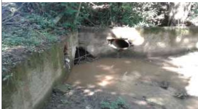
Foto: 1767958284706.jpg ID: 14 Visão geral da drenagem, Detalhe do canal, detalhe para intervenções no canal
