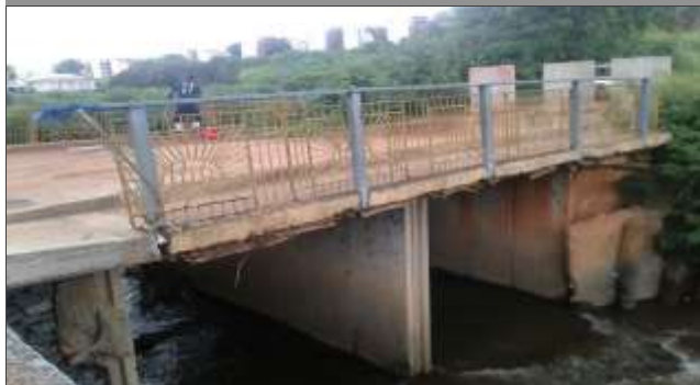
Foto: 1767892028695.jpg ID: 11 detalhe para intervenções no canal
