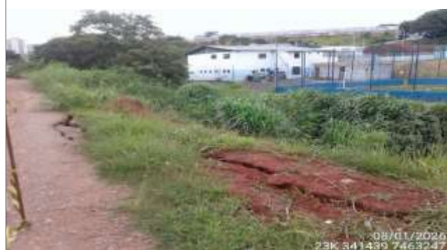
Foto: 1767877443784.jpg ID: 12 Detalhe para processo de ravinamento
