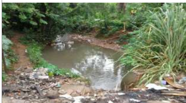
Foto: 1768306934863.jpg ID: 12 Visão geral da drenagem
