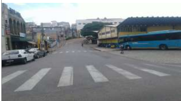
Foto: 1768237339531.jpg ID: 13 Limite da área atingida pelo processo, Imóveis afetados pelo processo
