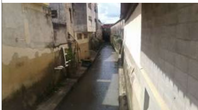
Foto: 1768234547209.jpg ID: 12 Detalhe do canal
