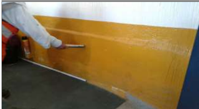
Foto: 1767956427093.jpg ID: 11 Detalhe para marca de água, Detalhe para nível de atingimento
