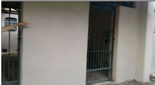
Foto: 1767977062944.jpg ID: 11 Detalhe para nível de atingimento
