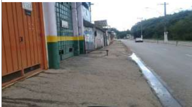
Foto: 1767893033045.jpg ID: 12 Imóveis afetados pelo processo
