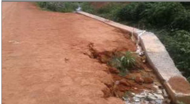
Foto: 1767889527995.jpg ID: 11 detalhe para intervenções no canal
