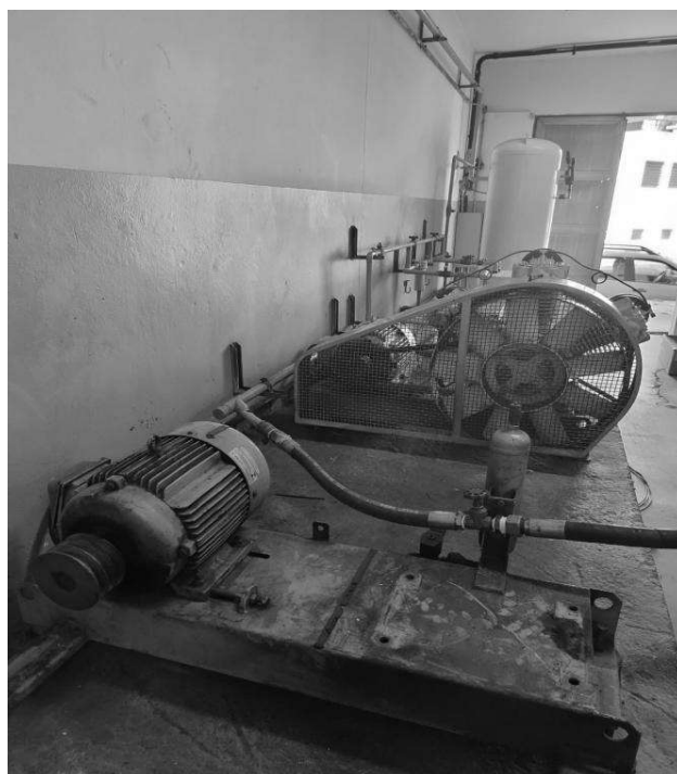
Central de ar comprimido
