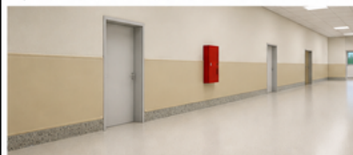
CORREDOR - PROTEÇÃO DE PAREDE EM PVC
