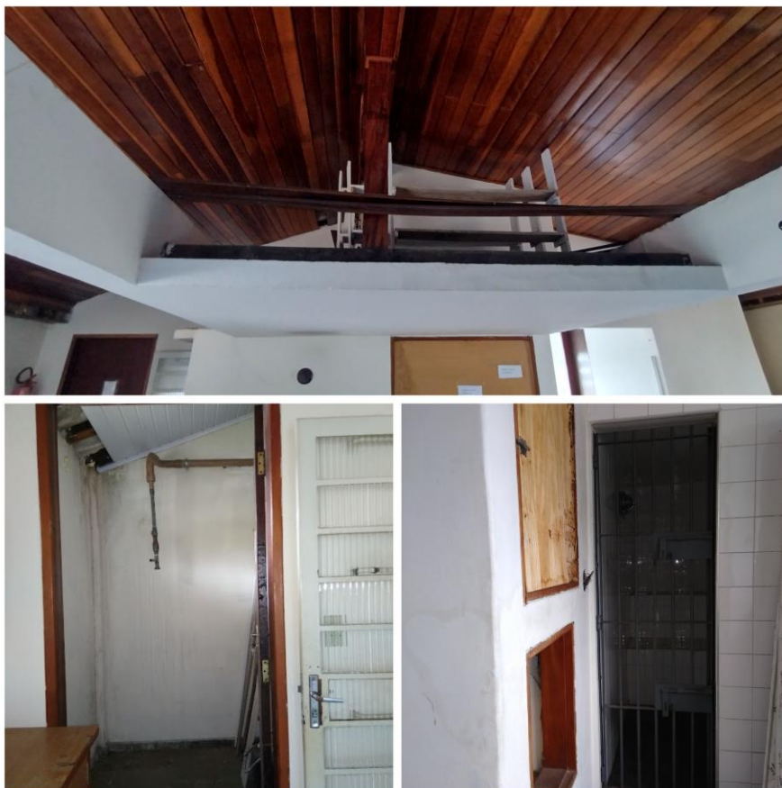
Foto 16 - Mezanino - Sauna - Área Técnica
