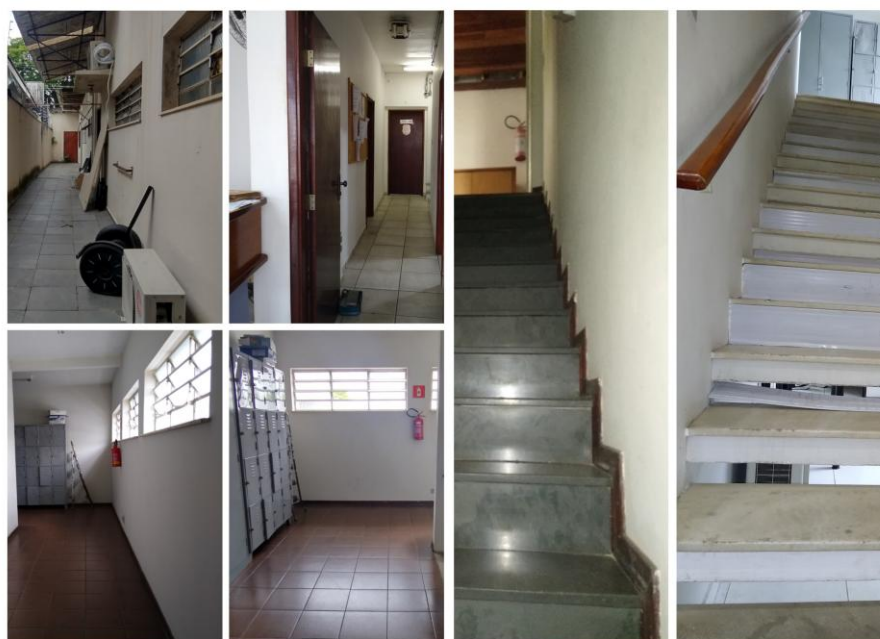
Foto 18 - Escadas e Corredores
