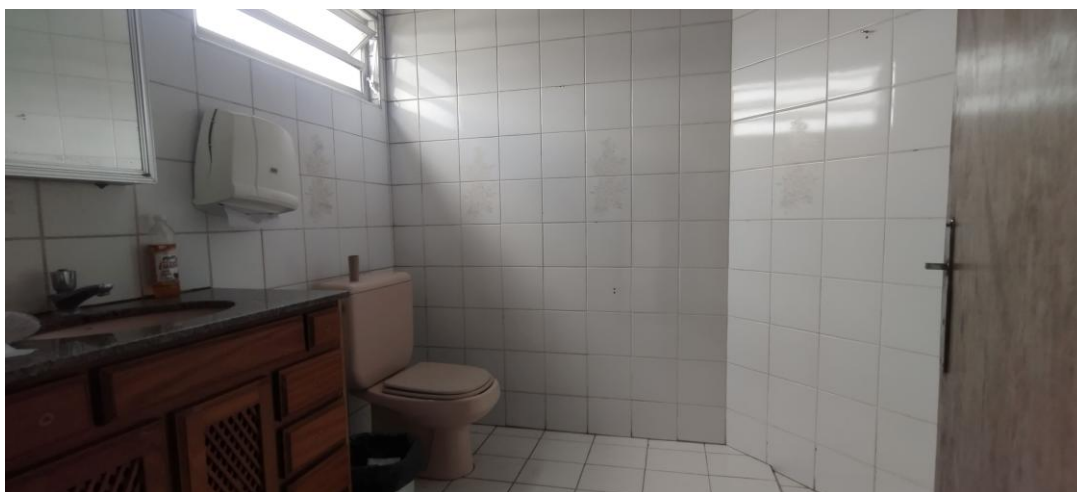
Foto 15 - Banheiro da Suíte Principal
