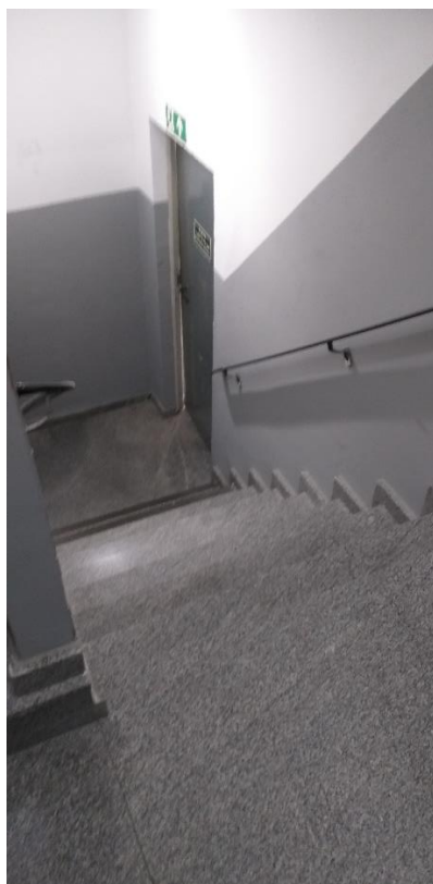
Foto 04 – Vista da escada de acesso aos pavimentos;
