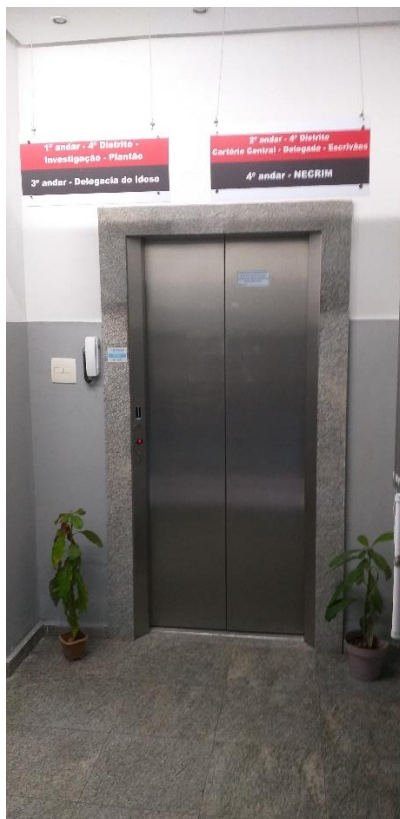
Foto 03 – Vista do elevador de acesso aos pavimentos;
