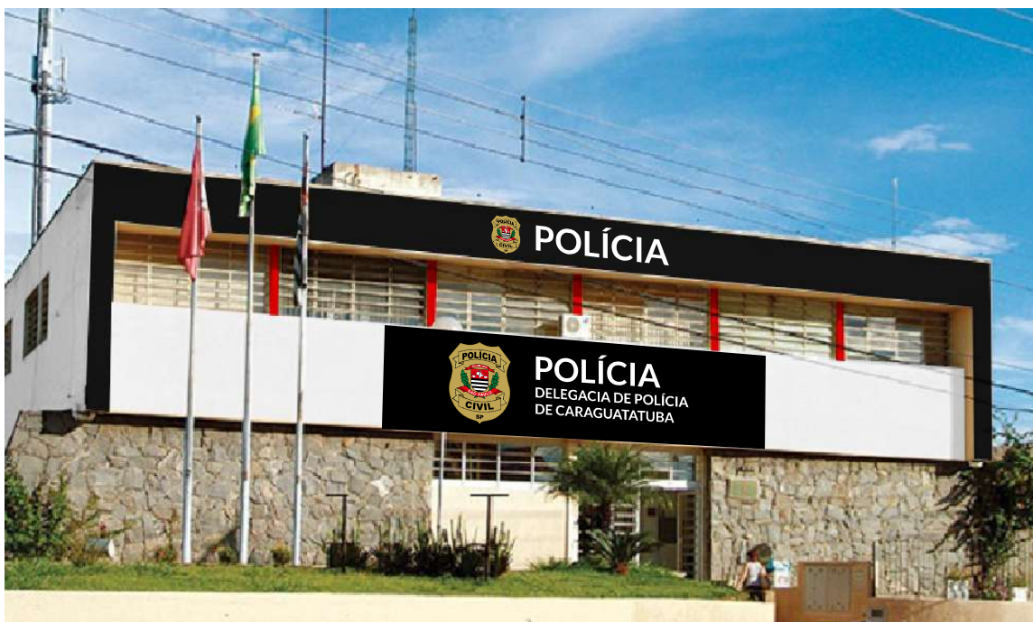
Aplicação em Fachada de Delegacia de Município
