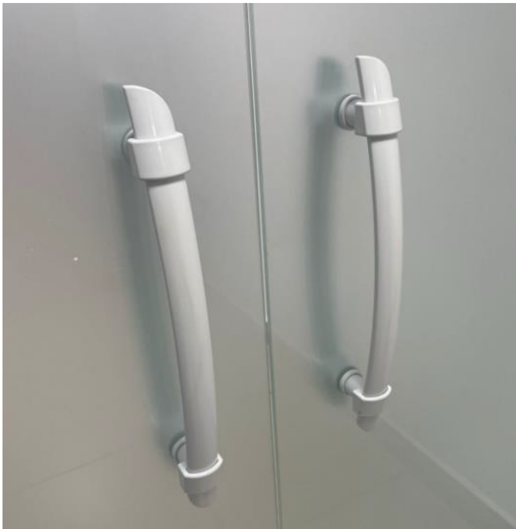
Fig 2: a) Puxadores em portas no mesmo ambiente; b) Medida total de 42 cm, medida de 30 cm entre furos; c) Puxadores em ambos os lados.
