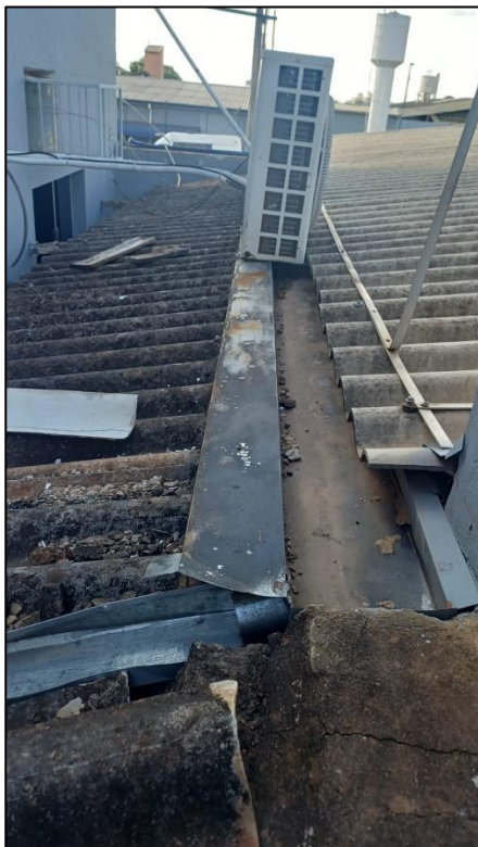
Figura 14 e 15: Calha a ser substituída entre o telhado da academia e o telhado a ser demolido do corredor da UIS. A condensadora esta fixada no rufo e será retirada e reinstalada na parede da edificação.
