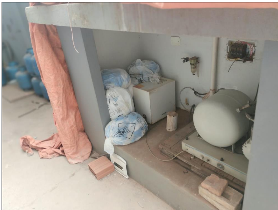
Figura 17: Instalação de portinhola ventilada / perfurada para a proteção do compressor de ar odontológico (vão de 1,10 x 1,36 m H x C).
