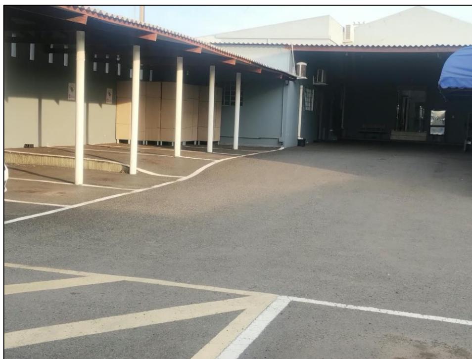
Figura 18: Situação 05 e 06 Instalação de calha na garagem a esquerda e na garagem ao fundo com condutores.
