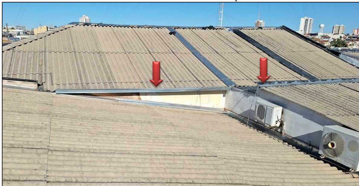
Figura 05: O telhado é servido por duas calhas colcho, com uma divisão por uma mureta no centro.
