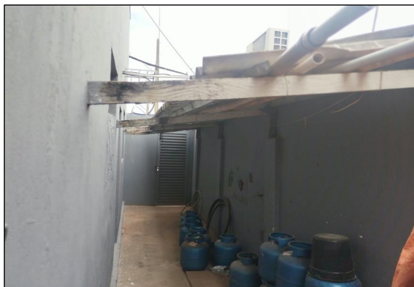
Figura 16: Telhado de uma agua em Eternit a ser demolido e reconstruído para abrigar um tanque de roupa. (Será instalado um tanque modelo comercial, com torneira, esgoto, iluminação e tomada)
