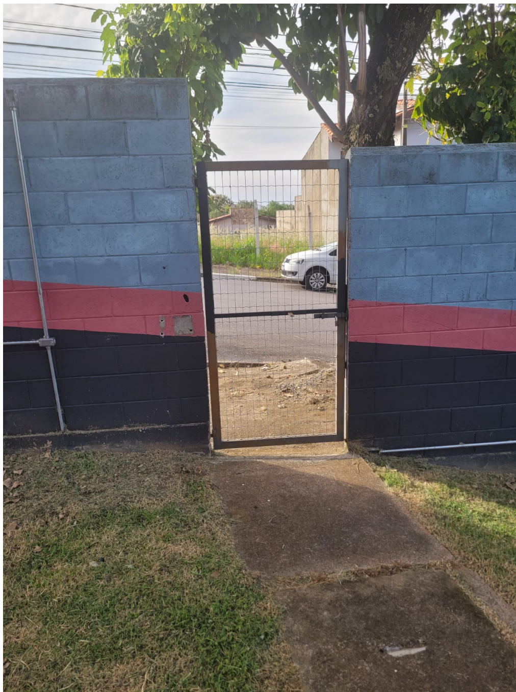
Imagem 3 – Portão lateral de acesso de pedestres na Rua Antonieta Corrêa dos Santos.
