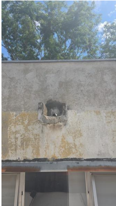
Foto número 06 – Local de escoamento de água pluvial
