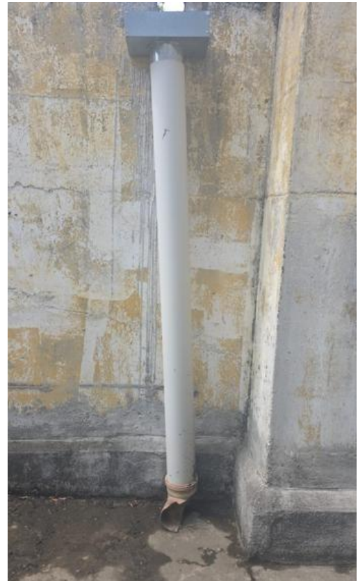
Fotos números 04 e 05 – Condutores de água pluvial
