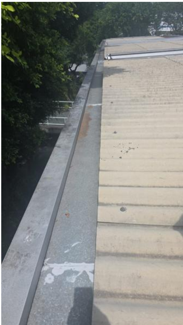
Foto número 08 – Calha de direcionamento da água pluvial
