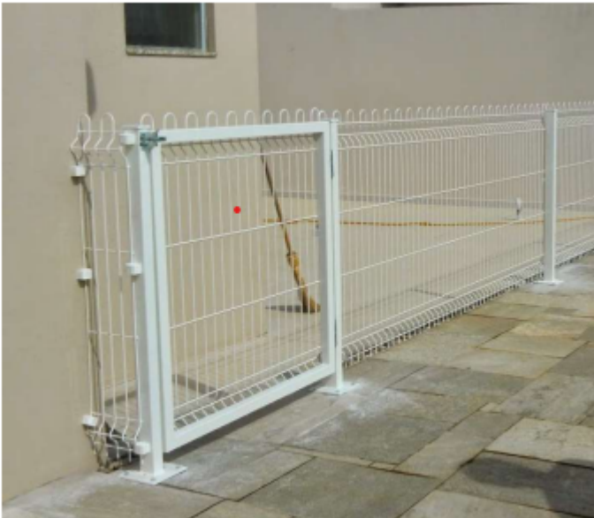
Foto: detalhe da porta e dos pilares de sustentação
