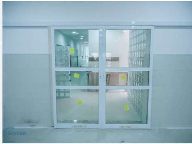
Figura 10 – Modelo de Porta com sistema de correr para fora do vão.
