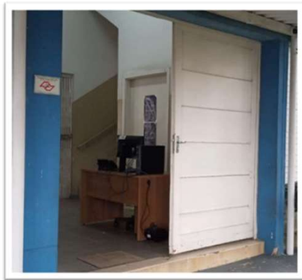
Figura 3 Foto do vão que será instalada a porta.
