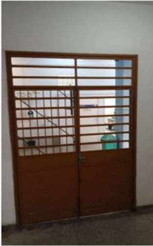
Figura 9 - Foto do vão onde será instalado
