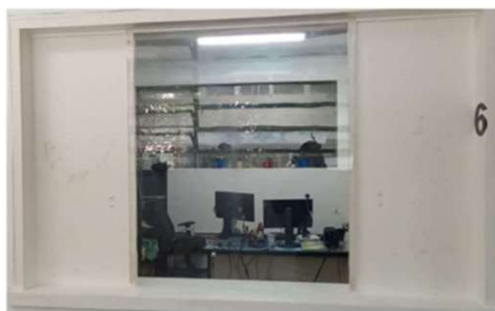
Figura 7 – Foto do vão onde será instalada o vidro fixo – guichê
