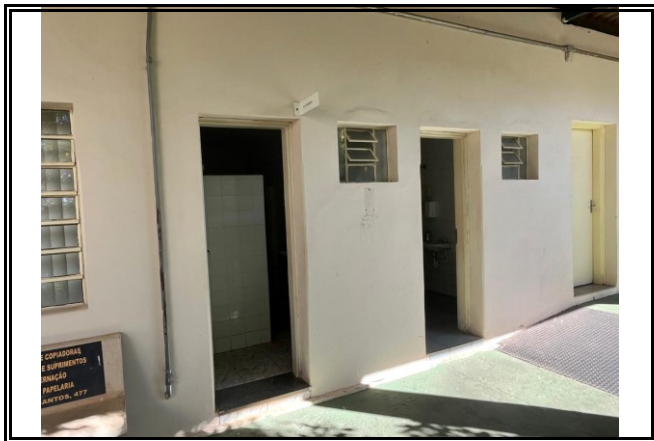
Fachada dos dois sanitários de uso público
