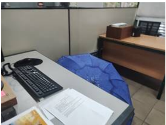
FOTO 03 -DIVISÓRIA PARA REMOÇÃO
