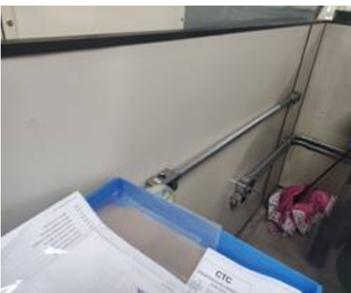
FOTO 04 DIVISÓRIA PARA REMOÇÃO
