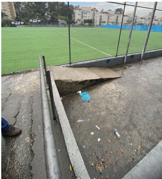
FOTO 3 – RAMPA DE ACESSO
