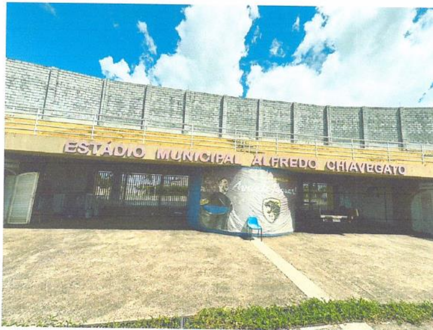
Foto 3: Entrada do Estádio
