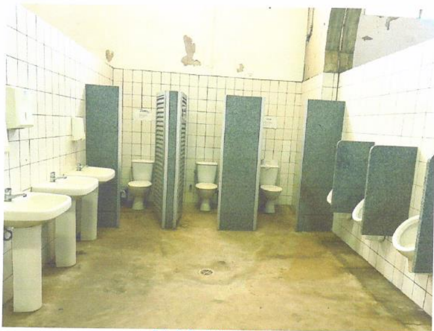
Foto 5: Banheiro do vestiário
