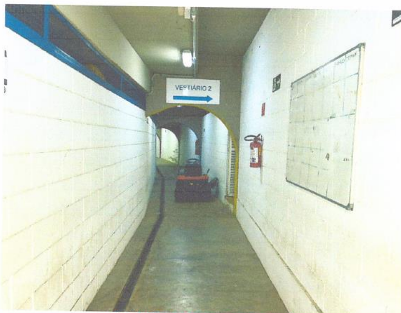
Foto 9: Corredor de acesso aos vestiários
