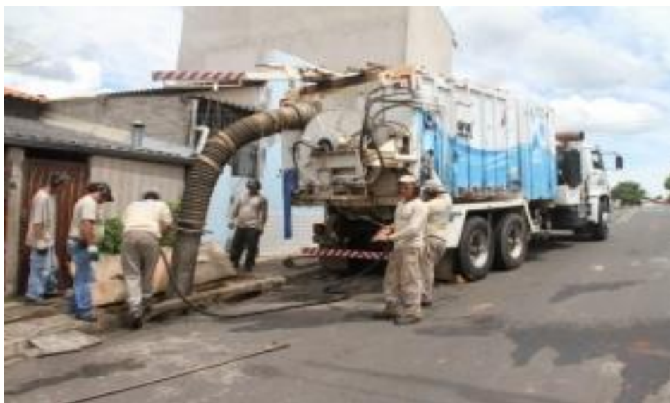
Figura 65 - Limpeza de Boca de Lobo com Caminhão Especial (limpeza a vácuo).
