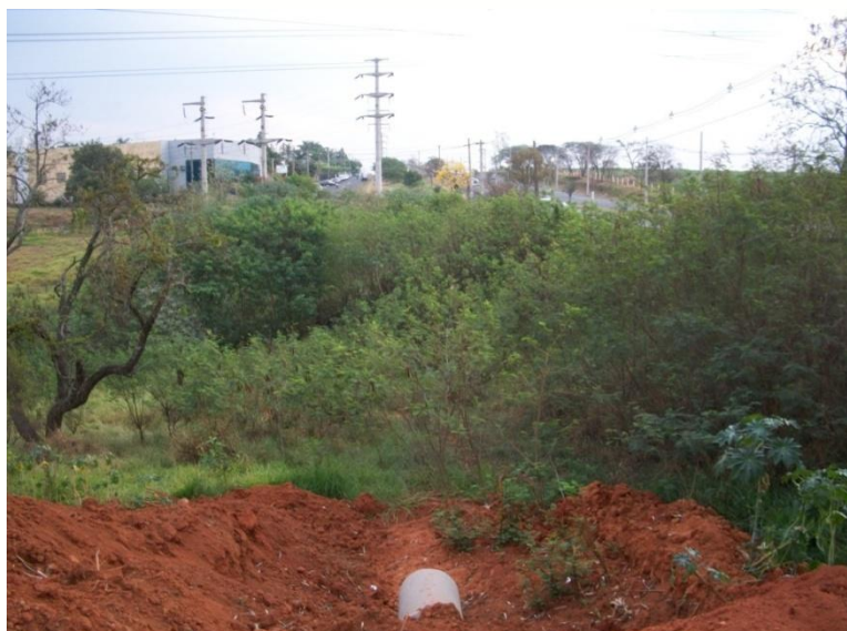
Figura 40 - Vista Ponto de Descarga da Galeria.
