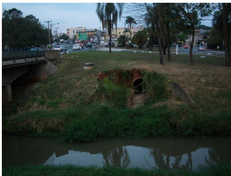
Figura 45 - Erosão no Desemboque de uma Galeria de Águas Pluviais no Ribeirão dos Toledos.
