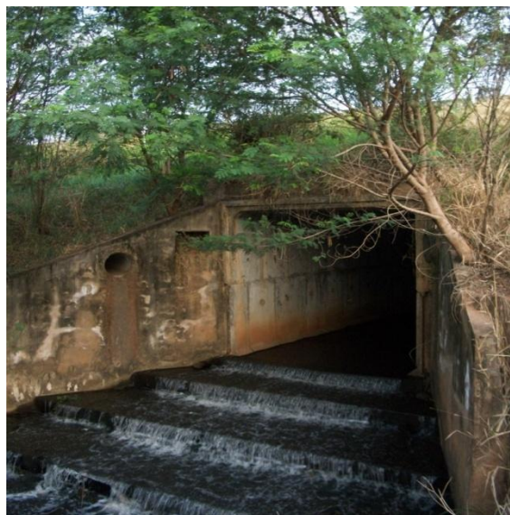
Figura 31 - Estrutura de Passagem Ponte Funda.
