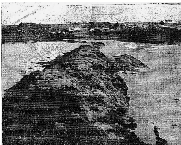
Figura 27 - Diques rompidos pela ação das águas em maio de 1983 – Fonte Jornal d'Oeste – 30 de junho de 1984 (reprodução).
