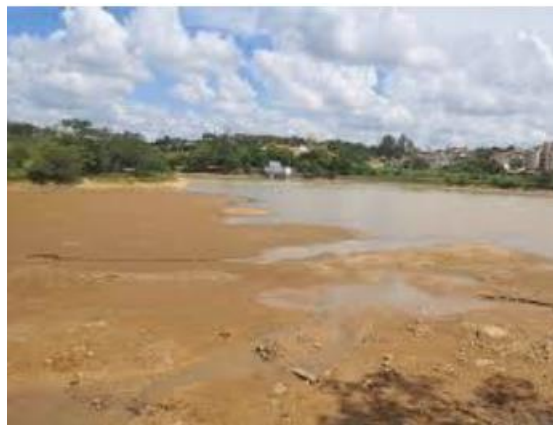
Figura 4.7. Vista do Barramento na represa 1 durante a estiagem
