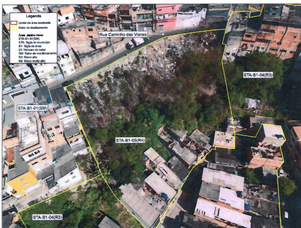
Foto FO-STA-B1.03: Vista parcial dos setores mapeados.
