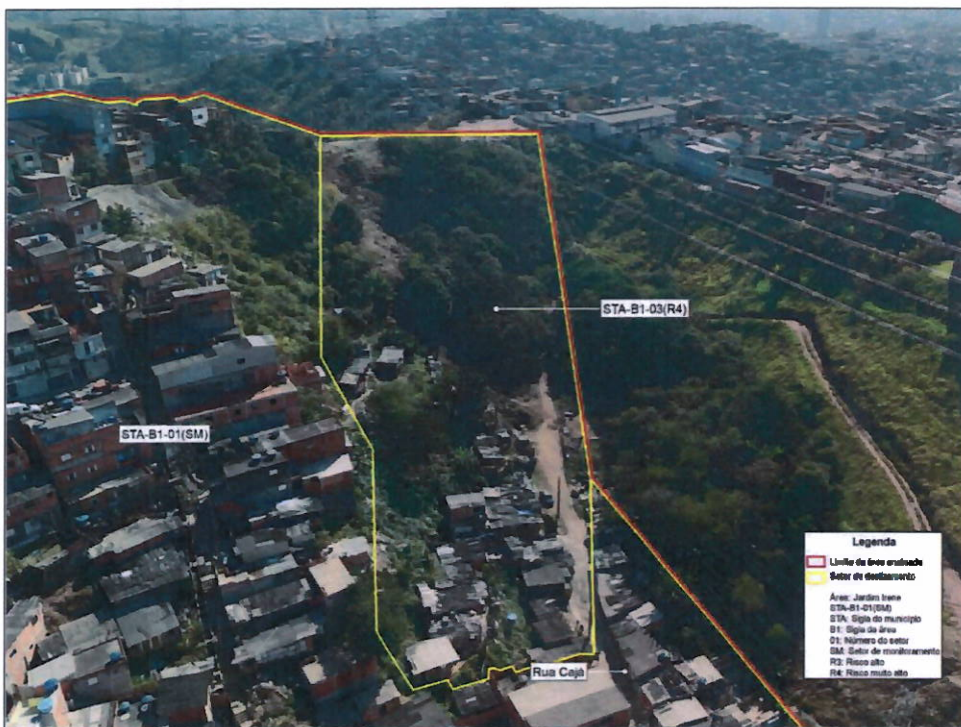
Foto FO-STA-B1.02: Vista parcial dos setores mapeados.
