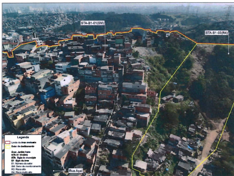
Foto FO-STA-B1.01: Vista parcial dos setores mapeados.
