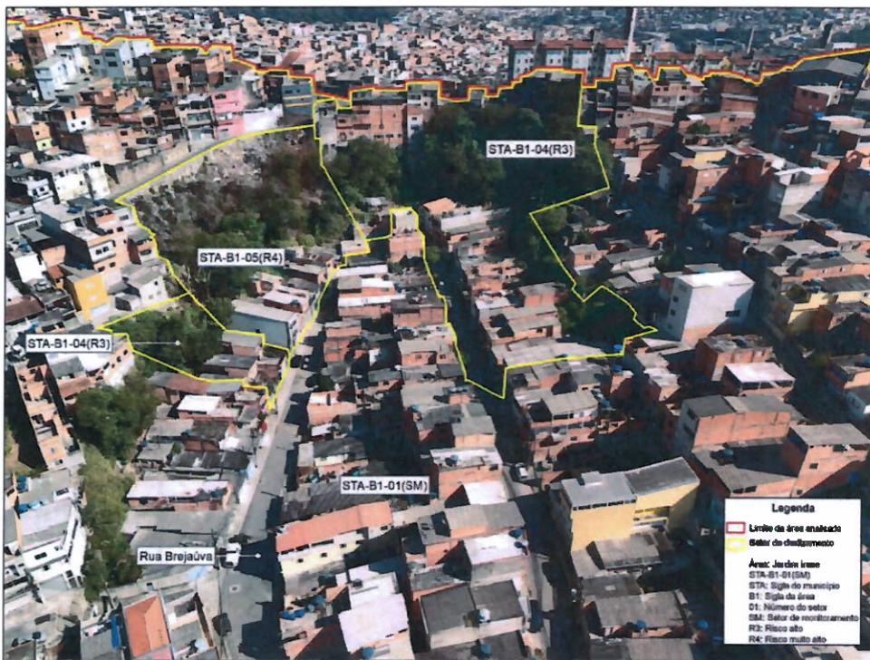
Foto FO-STA-B1.04: Vista parcial dos setores mapeados.
