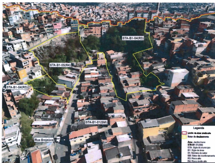
Imagem 5: Fonte: PMRR 24/25 de Santo André – Setores de risco 3 e 4 do Jardim Irene
