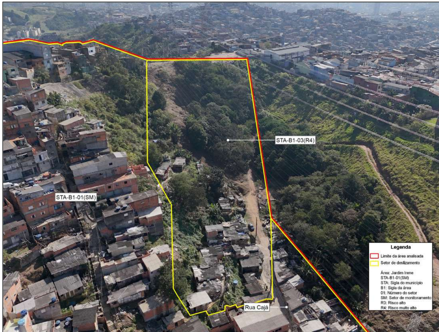
Foto FO-STA-B1.02: Vista parcial dos setores mapeados.
