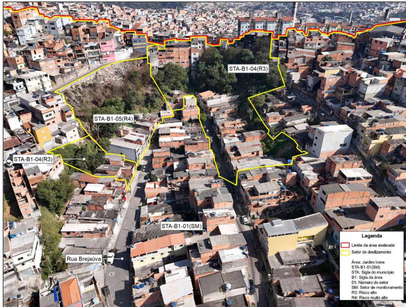
Foto FO-STA-B1.04: Vista parcial dos setores mapeados.
