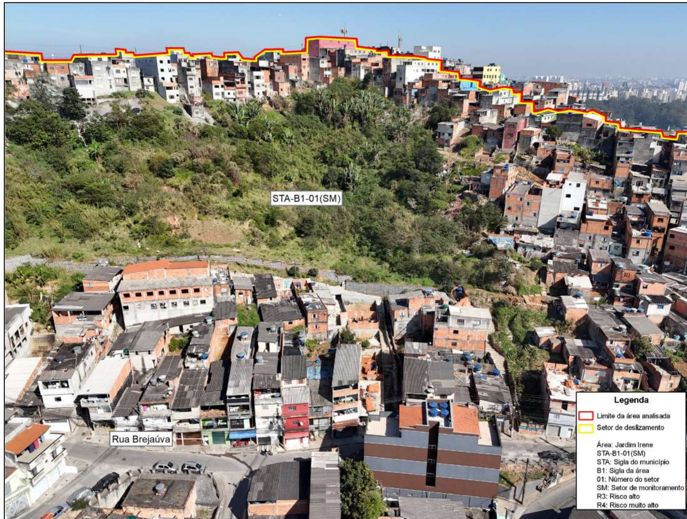
Foto FO-STA-B1.05: Vista parcial dos setores mapeados.
