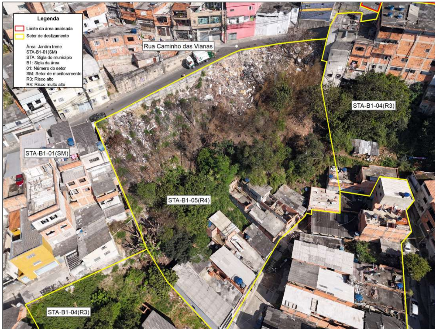
Foto FO-STA-B1.03: Vista parcial dos setores mapeados.
