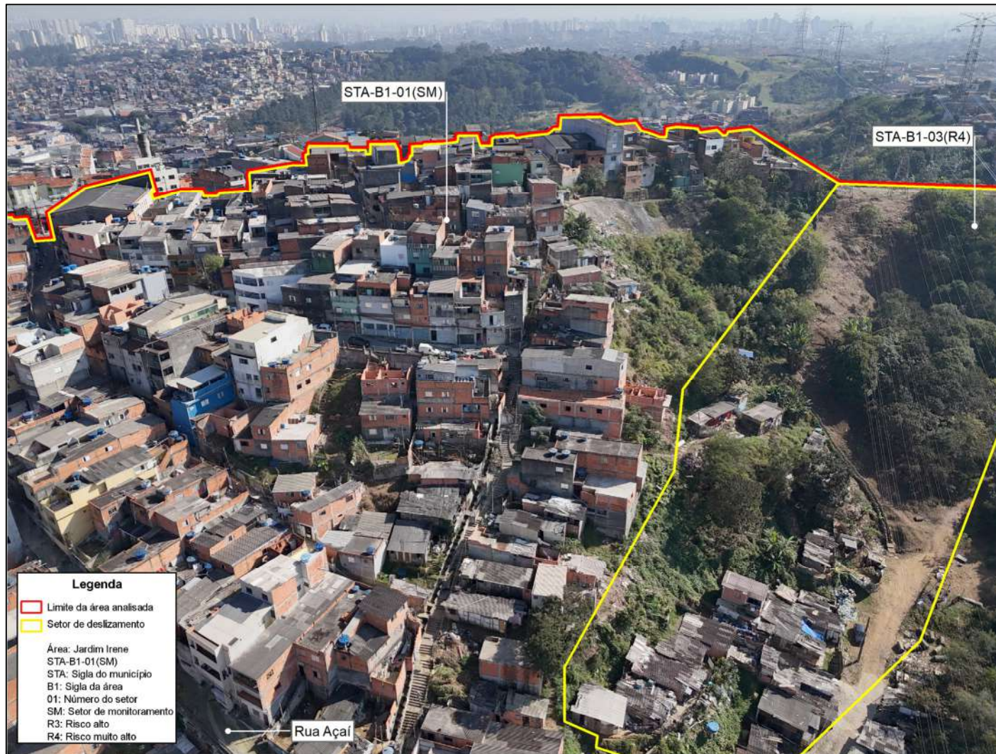
Foto FO-STA-B1.01: Vista parcial dos setores mapeados.
