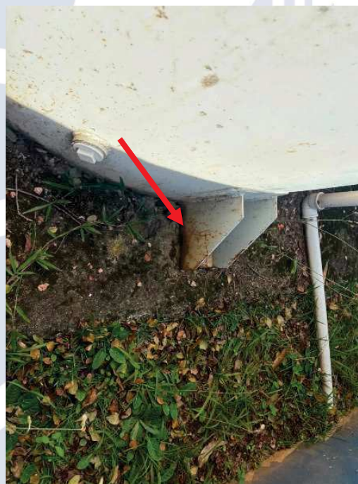
Figura 9 - Conforme evidenciado na Figura 4.
