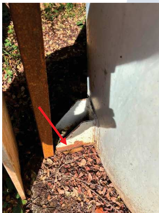
Figura 8 – Conforme evidenciado na Figura 4.
