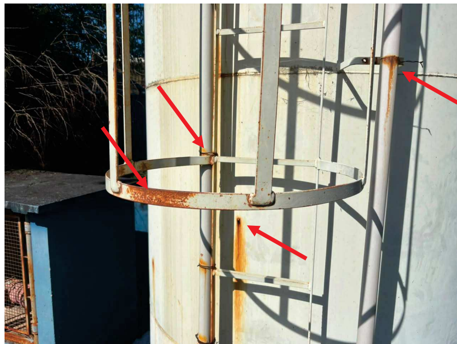
Figura 7 - Conforme evidenciado na Figura 4.
