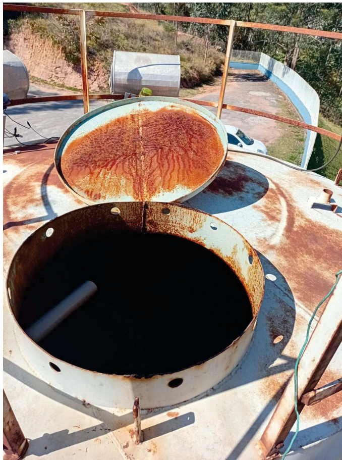
Figura 17 - Conforme evidenciado na Figura 4.
