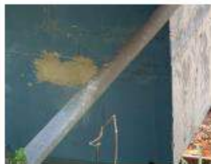
Foto 12: fechamento dos furos com aploamento dos agregados e aplicação de graute de 70,0 Mpa.
