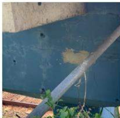
Foto 13: após o apiloamento dos agregados e graute, fechamento dos furos.
