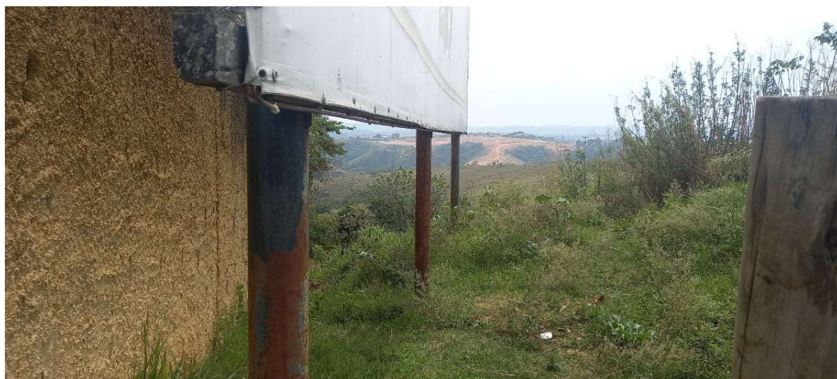
Foto 7: Vista muro de divisa entre o terreno destinado à UBS e o Cemitério das Colinas.
