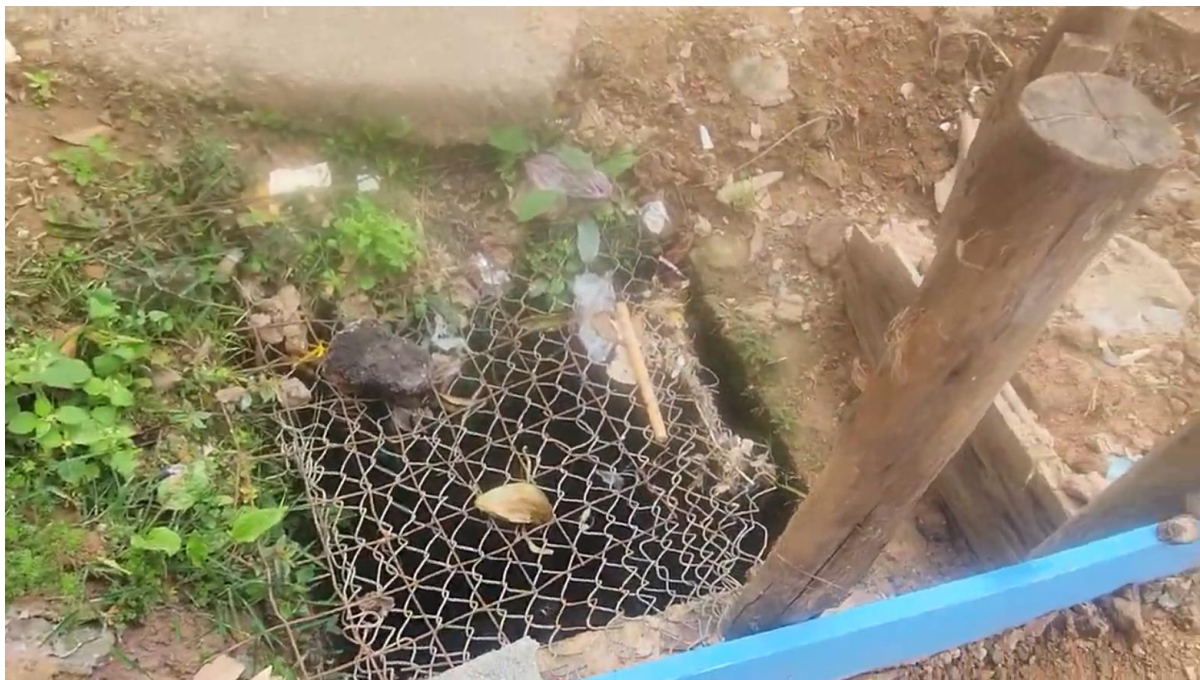
Foto 20: Poço de Visita Existente
