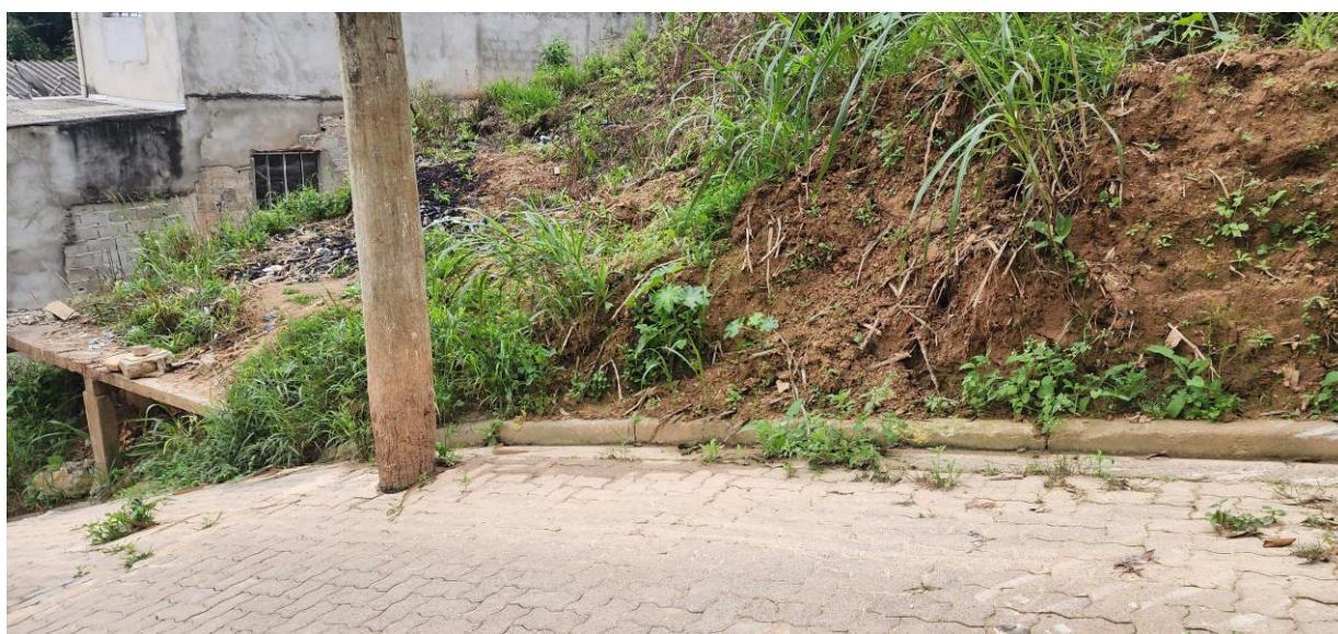
Foto 39: Poste na via
