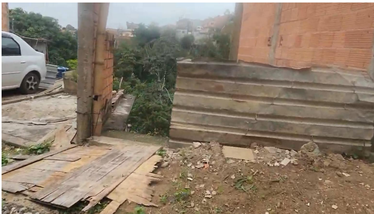
Foto 21: Entrada da Viela de Serviço
