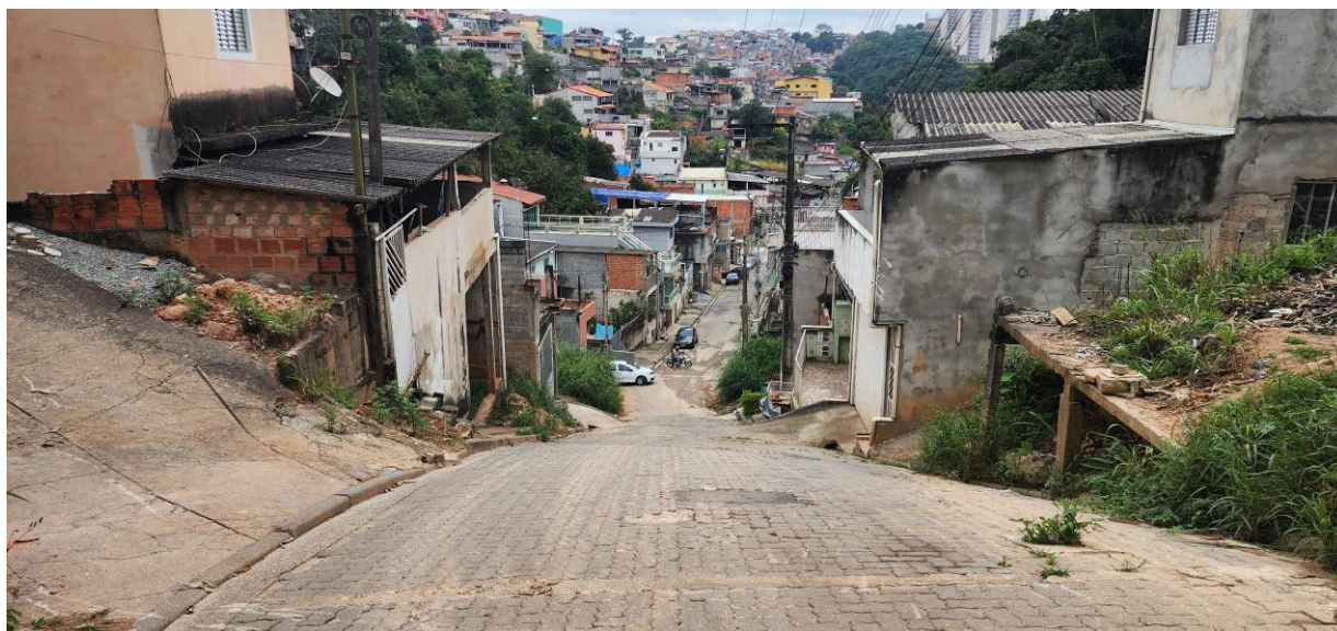
Foto 40: Vista da Rua
