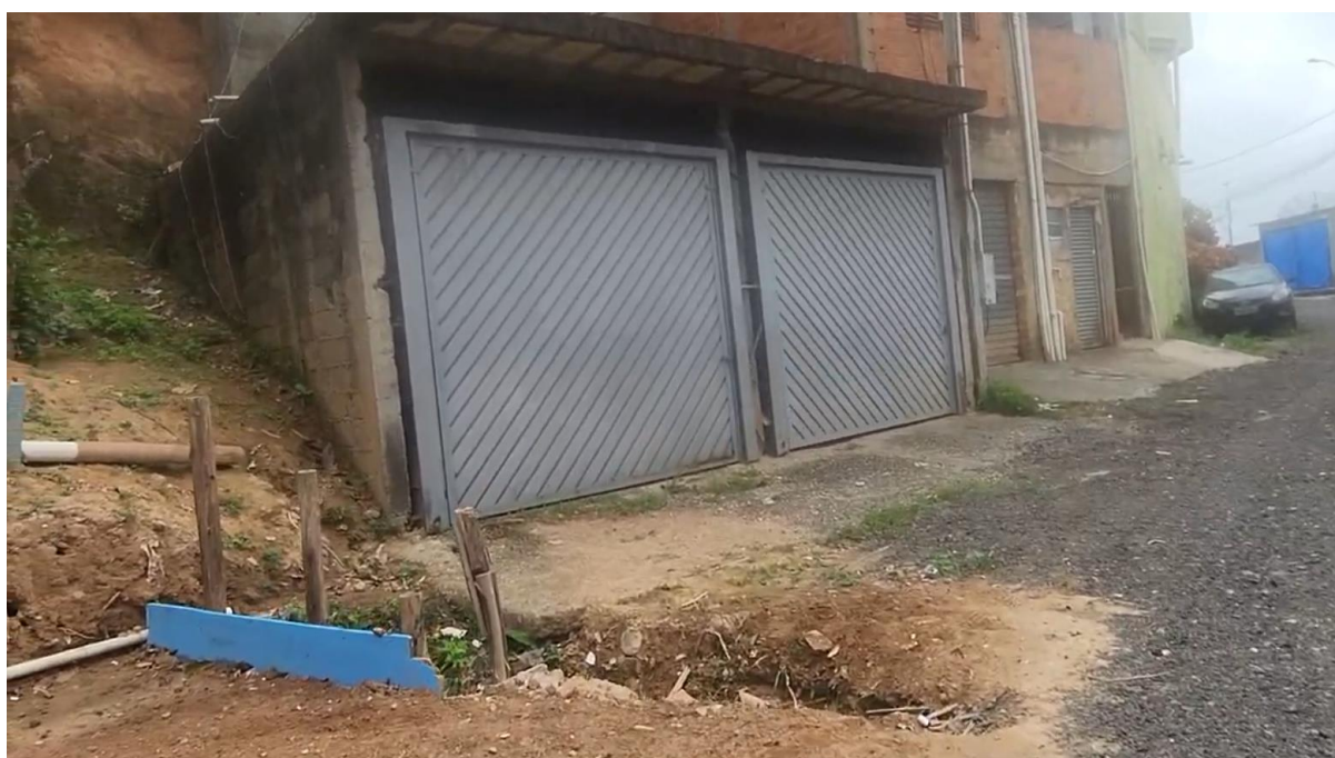
Foto 19: Poço de Visita Existente
