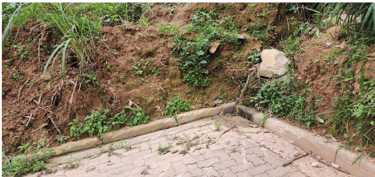
Foto 38: Detalhe do viradouro
