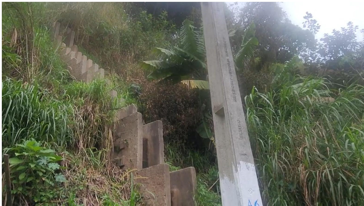
Foto 10: Escada Hidráulica em lote particular
