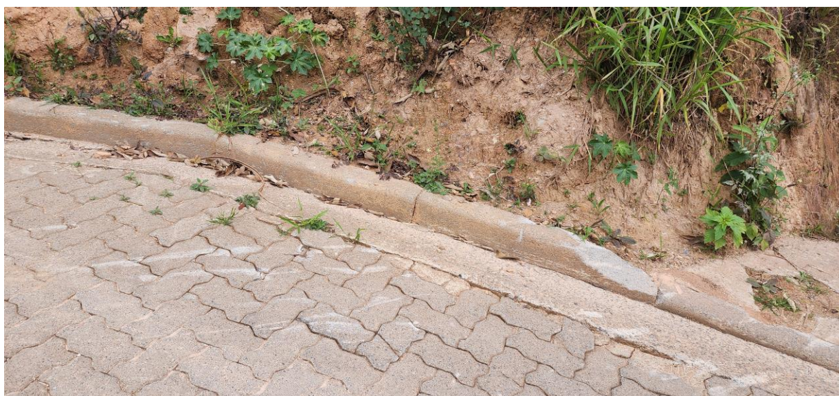
Foto 37: Detalhe do viradouro
