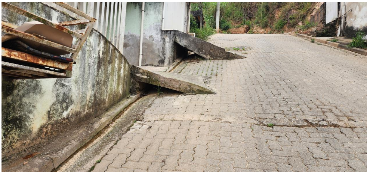
Foto 32: detalhe da rampa
